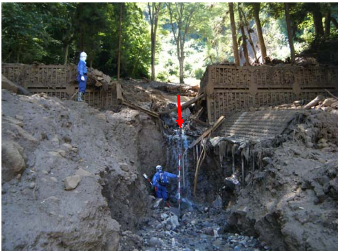
普段ほとんど水の流れない沢に人の背丈の2倍以上の高さの土石流が既設の堰堤を破壊しました
