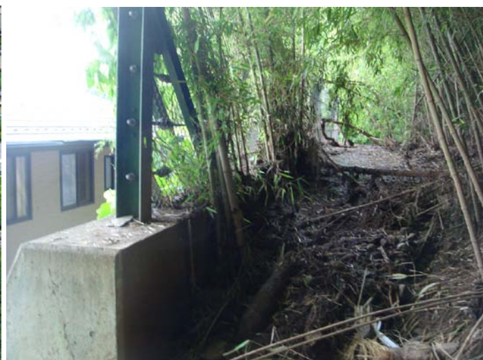
土砂を捕捉したコンクリート擁壁
