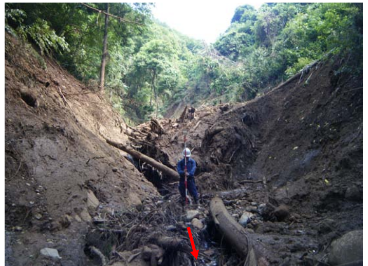
普段ほとんど水の流れない沢に人の背丈の2倍以上の高さの土石流が既設の堰堤を破壊しました
