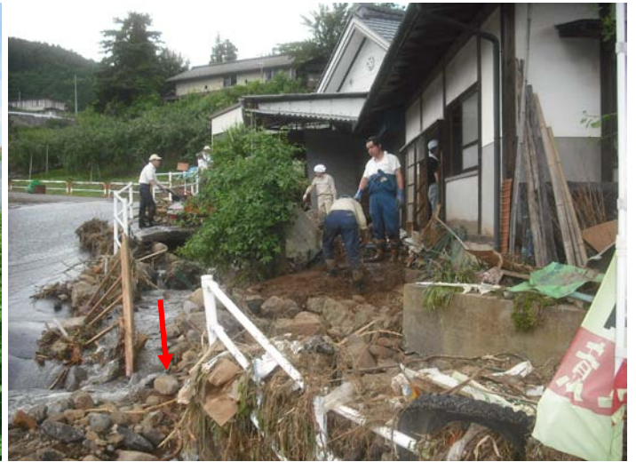
信更町田野口における床上浸水家屋
