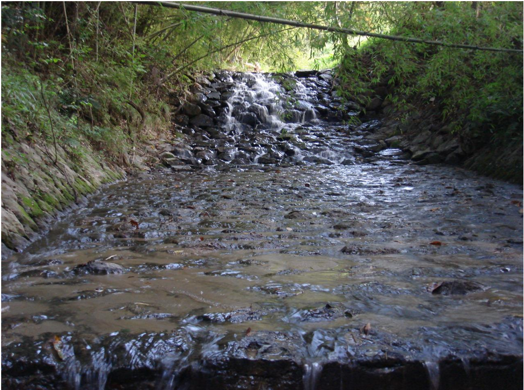
完成当時の姿が良く残っており、道からも近い第9号石張水路工
