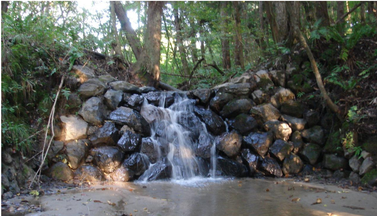
最上流にある第1号石張水路工
