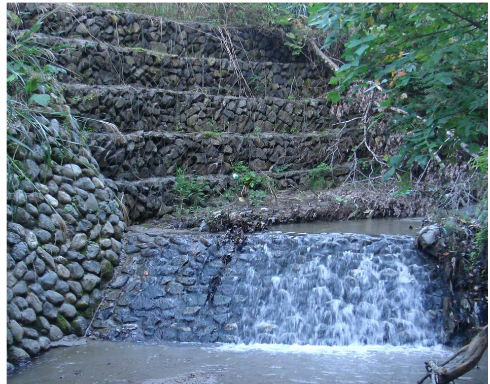
底以外は昭和になってから補修した第8号石張水路工
