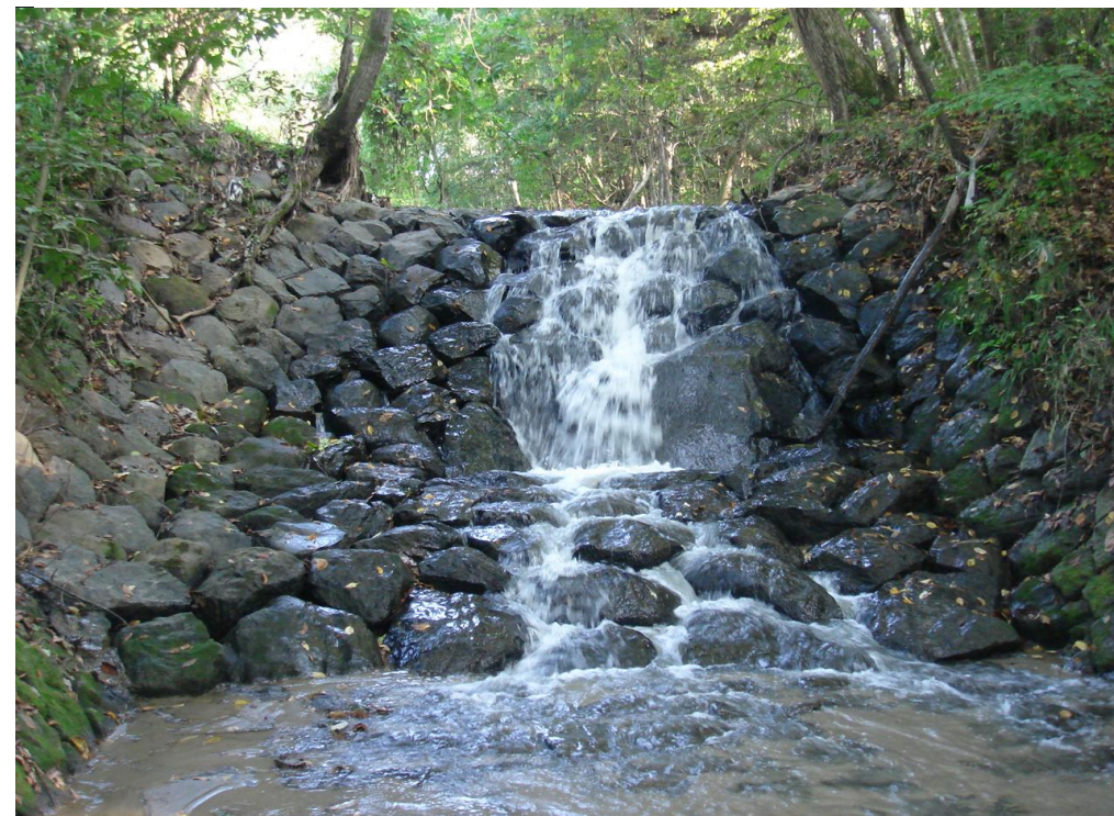
第12号石張水路工
