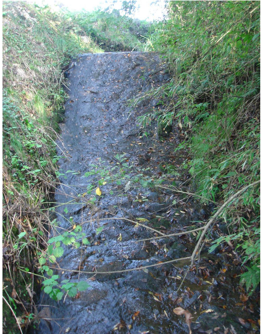
上部(左写真)下部(右写真)2段造られている第10号石張水路工
