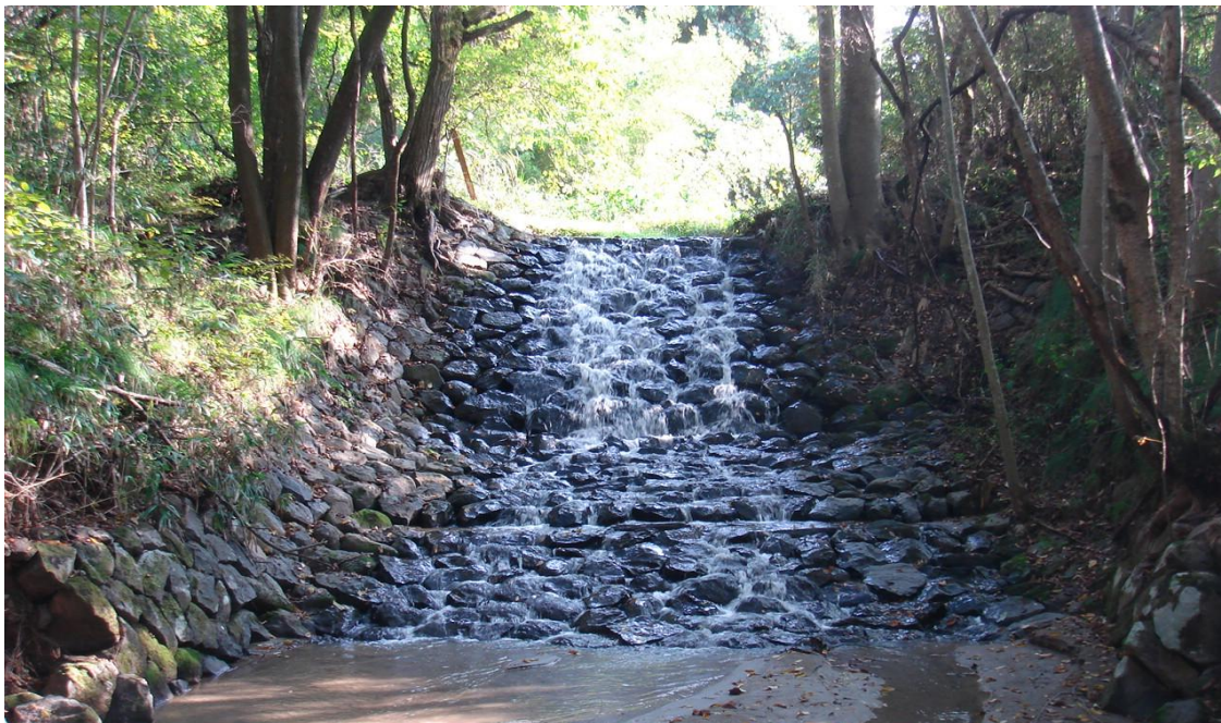
比較的規模の大きな第11号石張水路工
