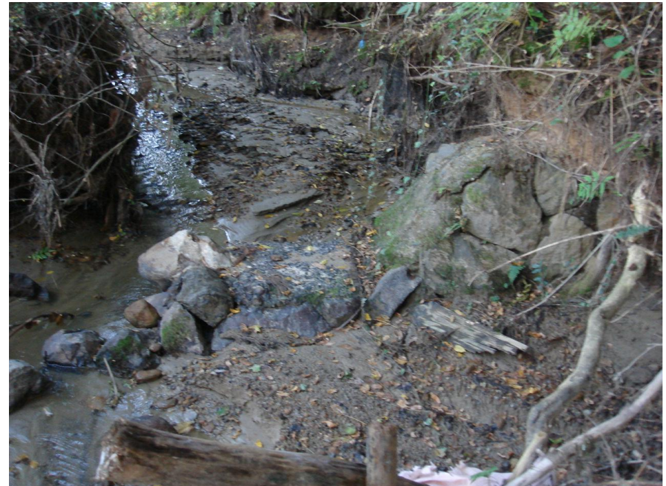
一部を残すだけの第4号石張水路工
