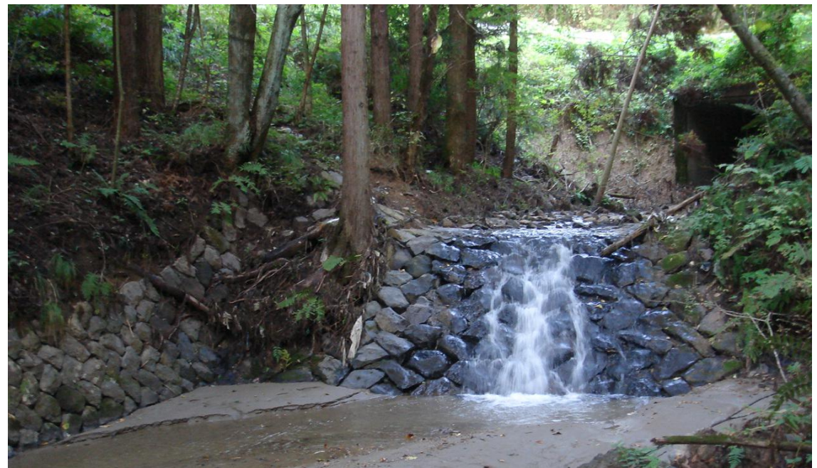
第6号石張水路工
