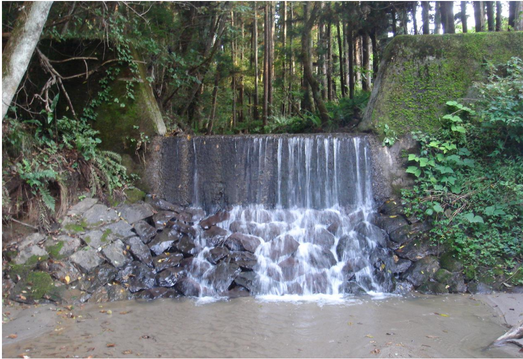
昭和になってから上部にコンクリート 堰堤を載せた第5号石張水路工
