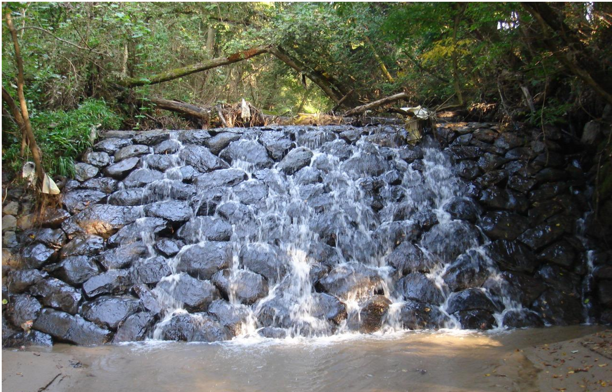
最下流にある第15号石張水路工
