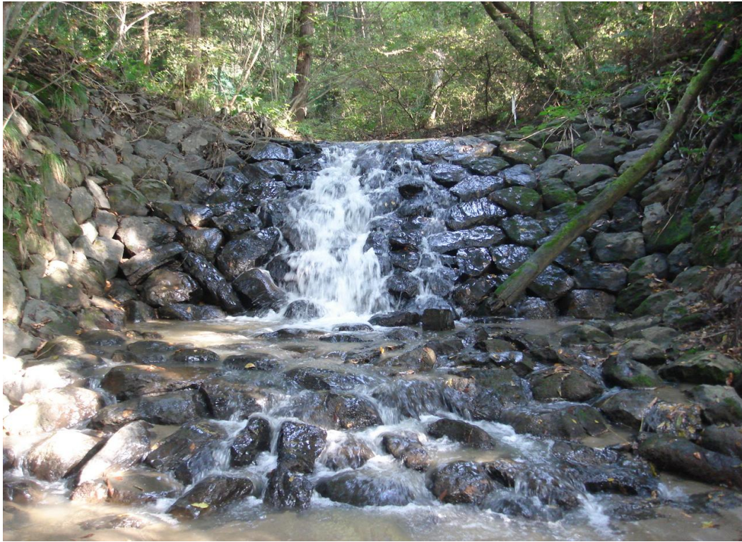
第13号石張水路工
