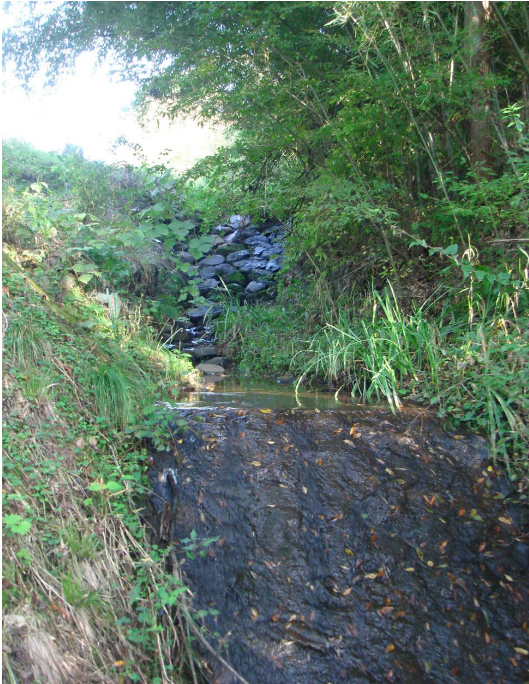
上部(左写真)下部(右写真)2段造られている第10号石張水路工
