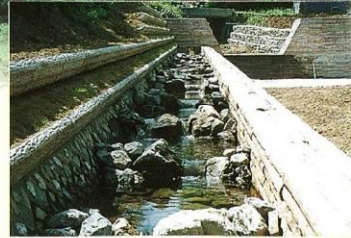
自然石張り魚道
