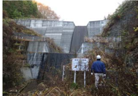
12箇所 異常なし 小川村絹張えん堤
