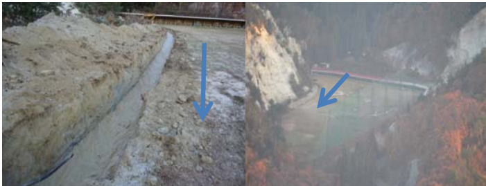
11月24日6:30~ 管内被災状況を確認するため ヘリによる調査を実施
