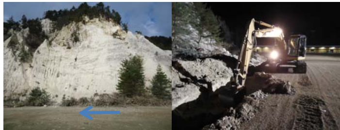
長野市小田切 滝沢 白土法面崩落により河道埋塞 バイパス水路を開削 20:15作業完了
