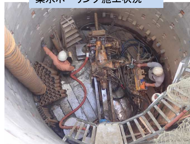
集水ボーリング施工状況
