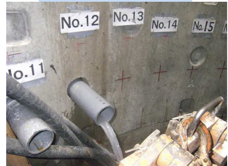
水抜きパイプから湧水の状況
