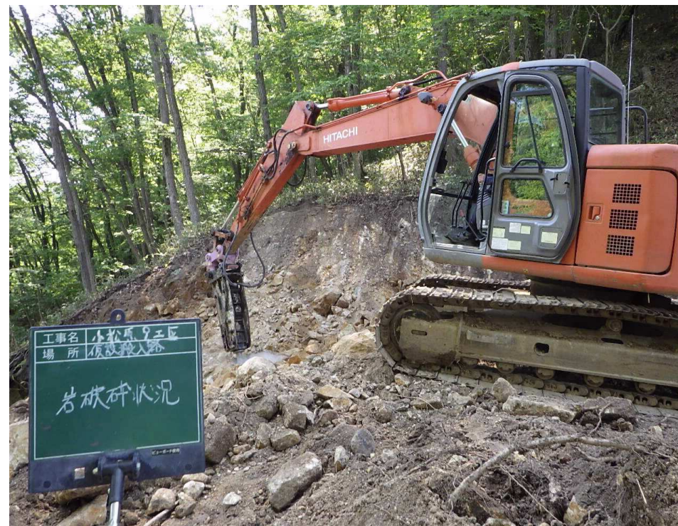
鋼管杭工事用道路施工状況
