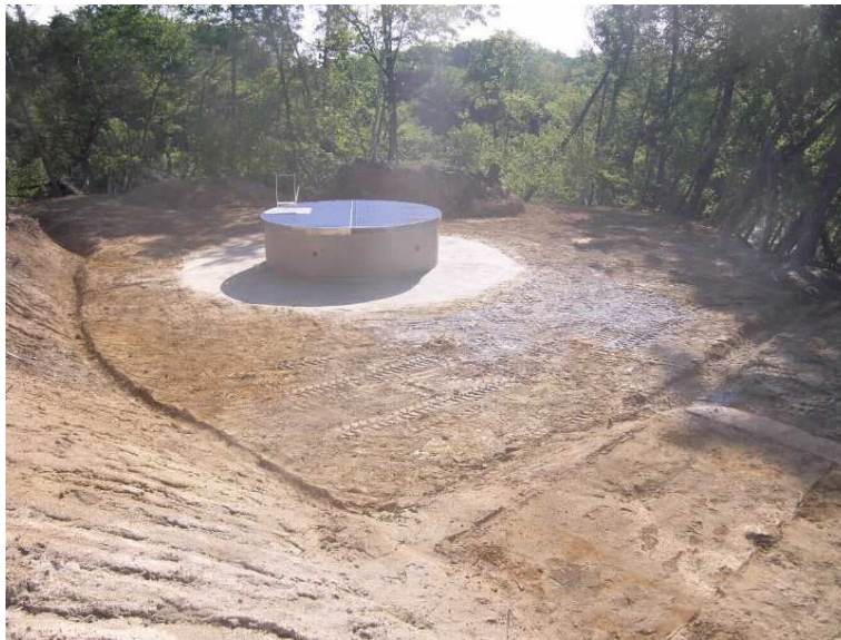
集水ボーリング施工完了
