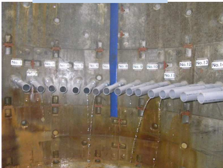
集水ボーリング施工完了
