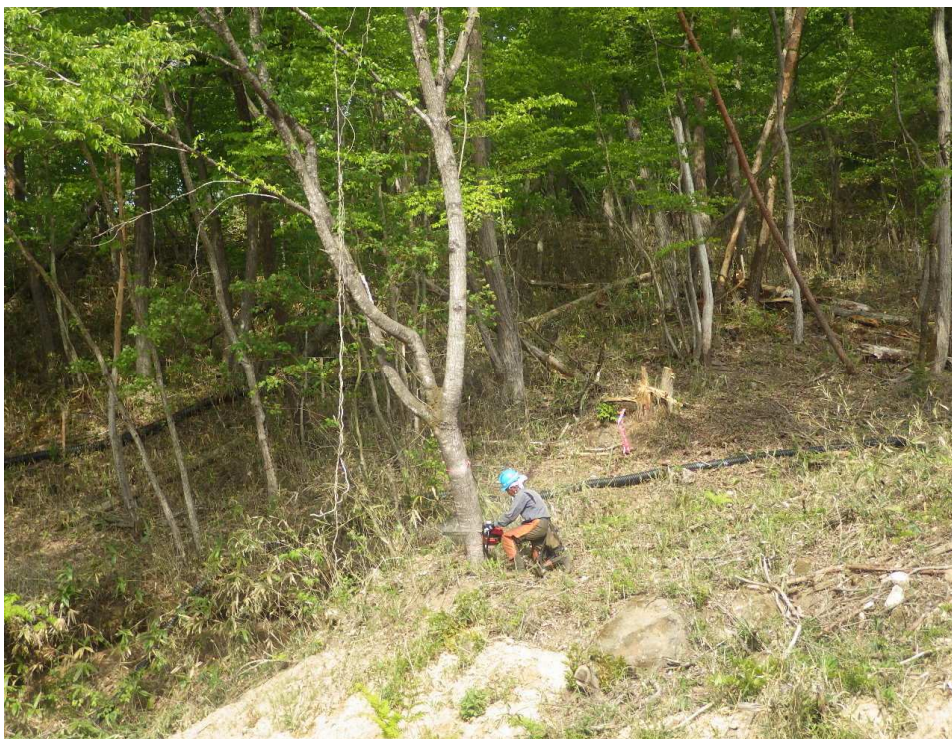
支障木除去状況
