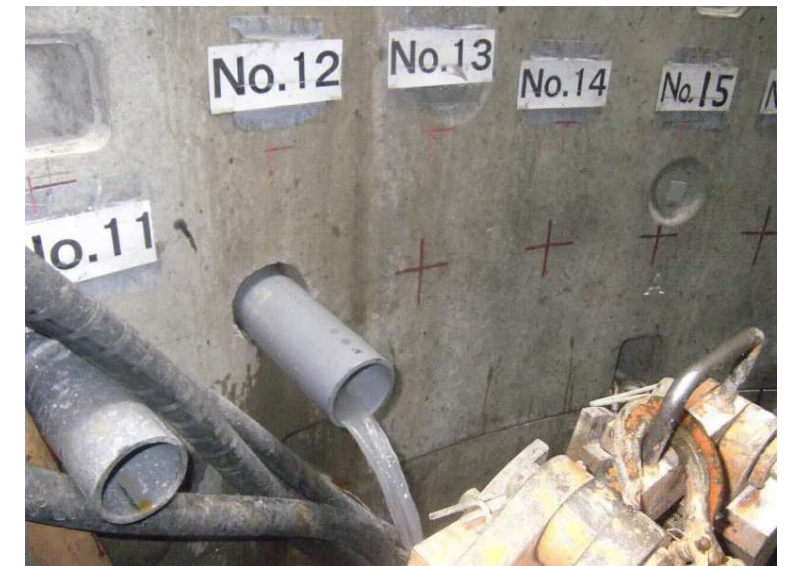
水抜きパイプから湧水の状況
