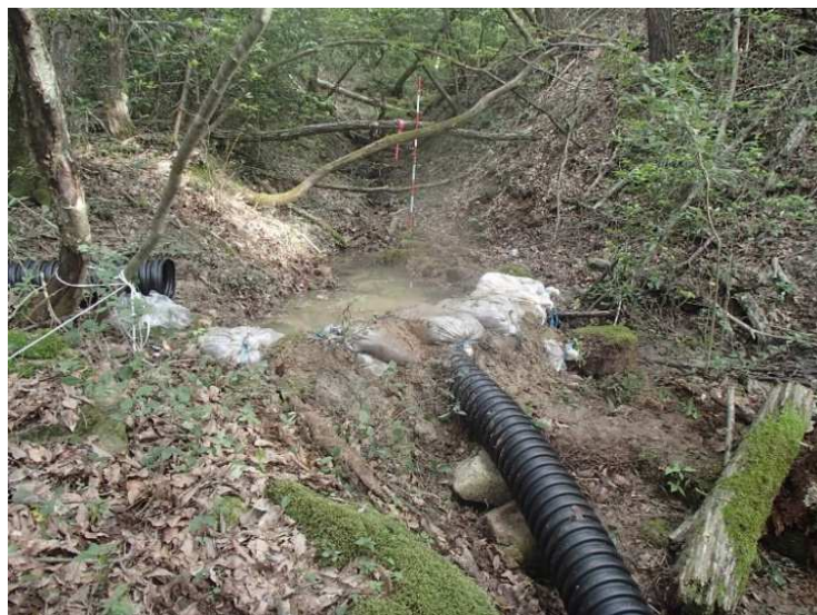
湛水池(左側方部)の仮排水設置状況 (角U400mm)
