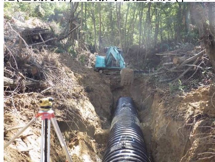
湛水池(左側方部)の仮排水設置状況 (φ1000mm)
