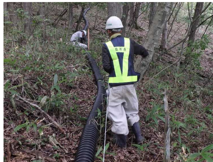
湛水池(左側方部)の仮排水設置状況 (φ1000mm)
