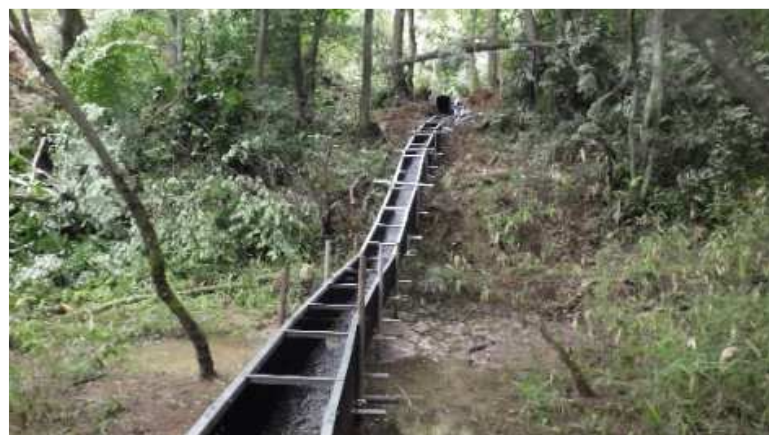
湛水池(左側方部)の仮排水設置状況 (角U400mm)
