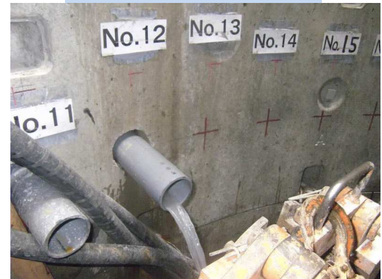
水抜きパイプから湧水の状況
