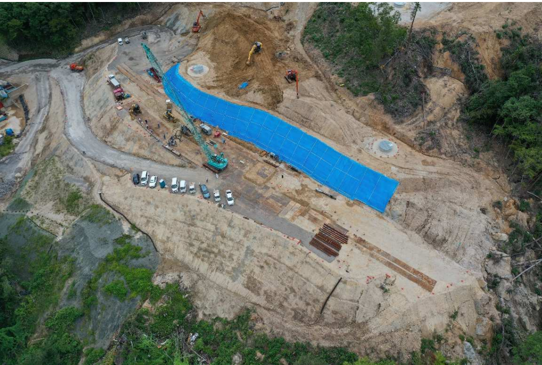
鋼管杭 工事用道路、施工ヤード
