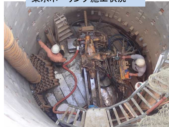
集水ボーリング施工状況
