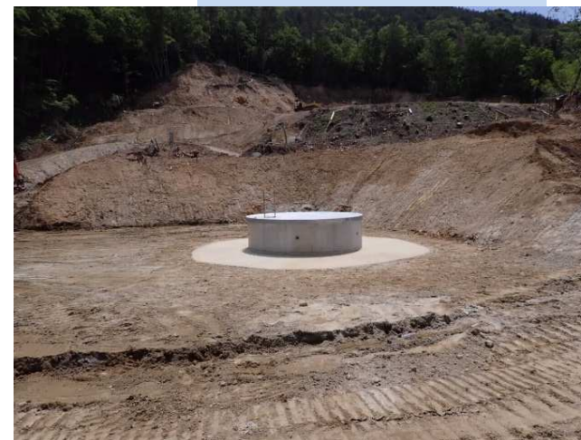
集水ボーリング施工状況
