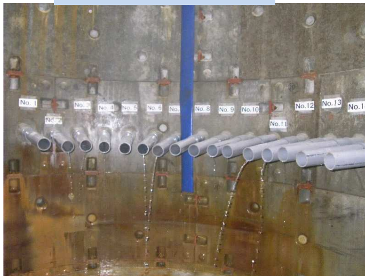
集水ボーリング施工完了
