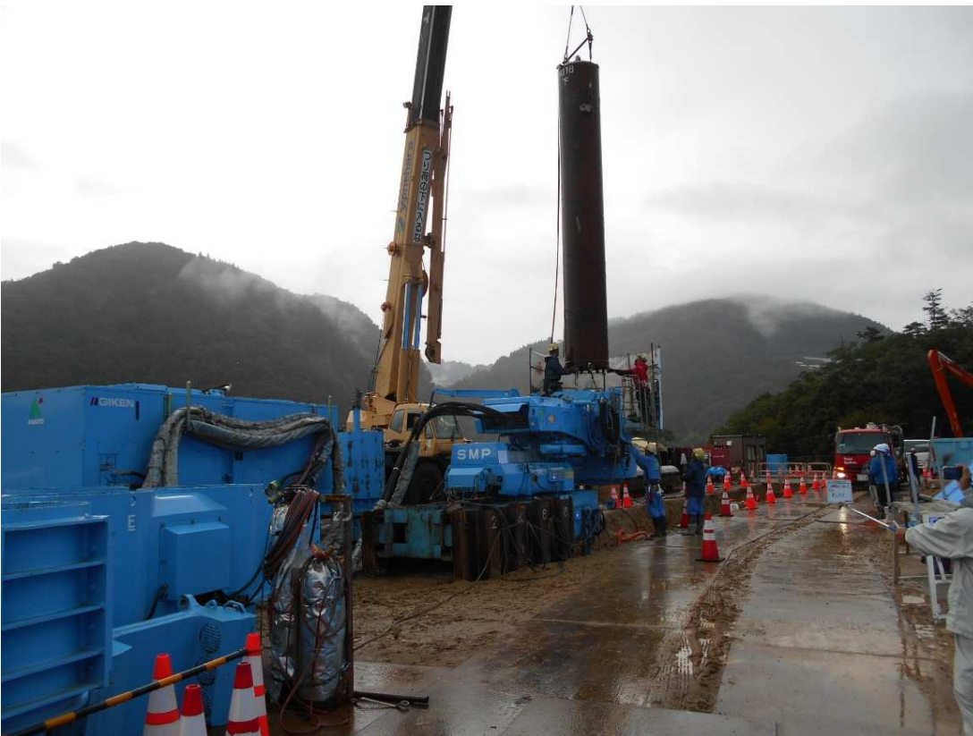
鋼管杭工 施工状況
