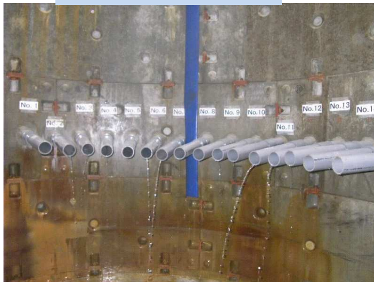
集水ボーリング施工完了
