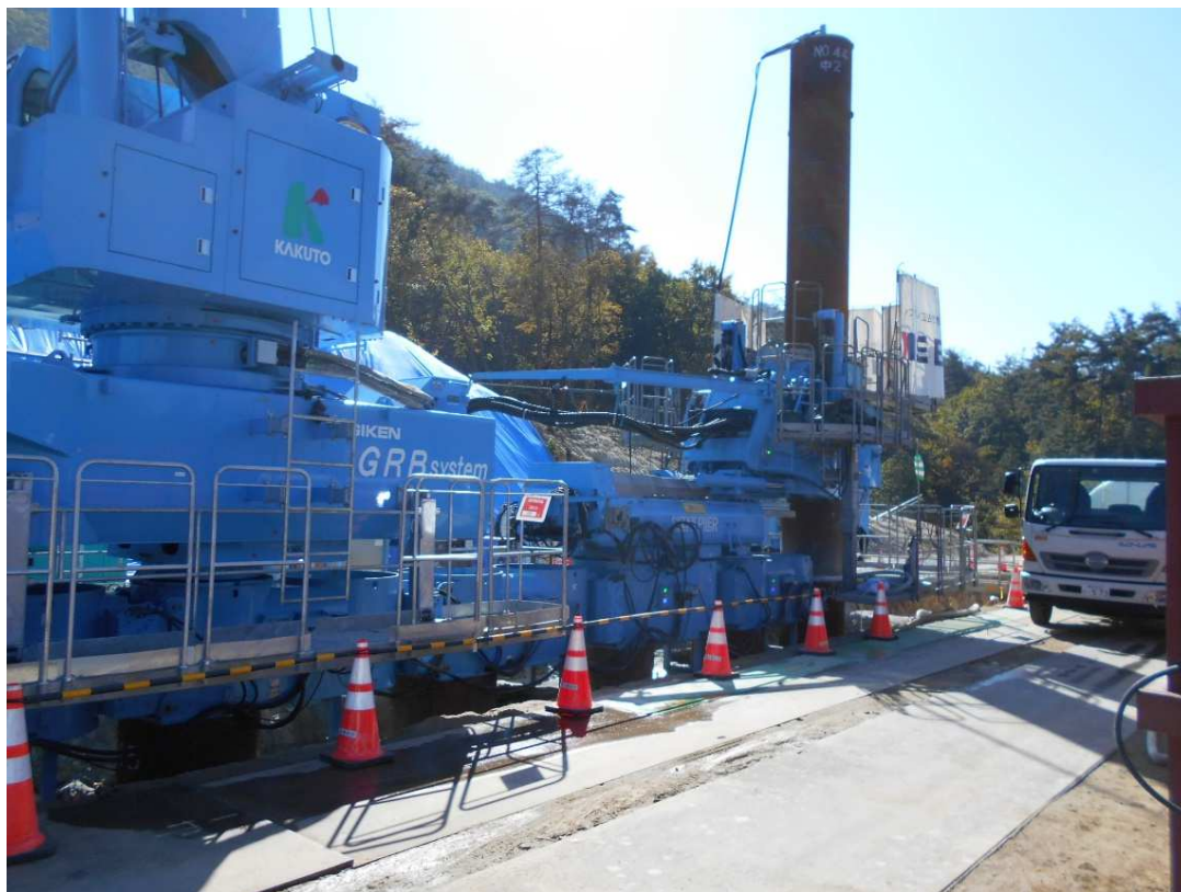
鋼管杭工 施工状況
