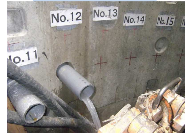
水抜きパイプから湧水の状況
