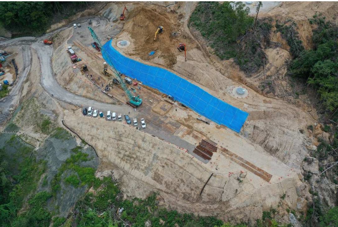
鋼管杭 工事用道路、施工ヤード
