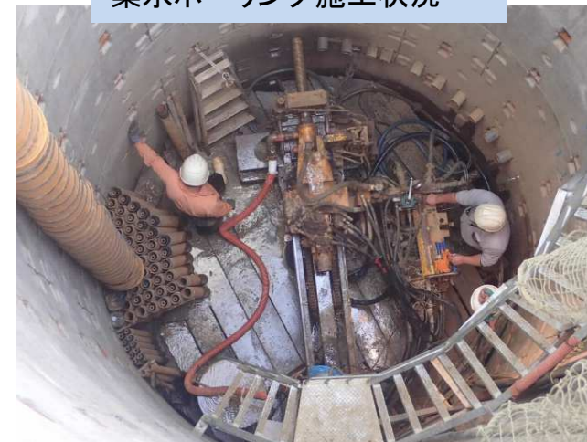
集水ボーリング施工状況
