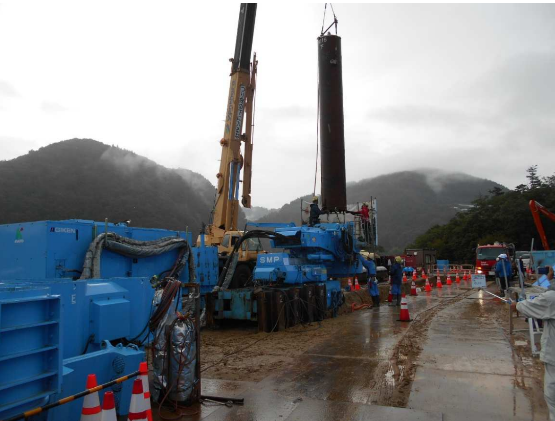
鋼管杭工 施工状況
