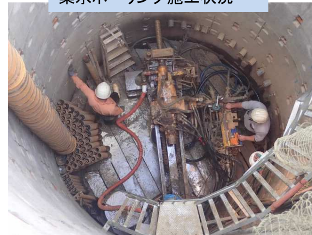
集水ボーリング施工状況
