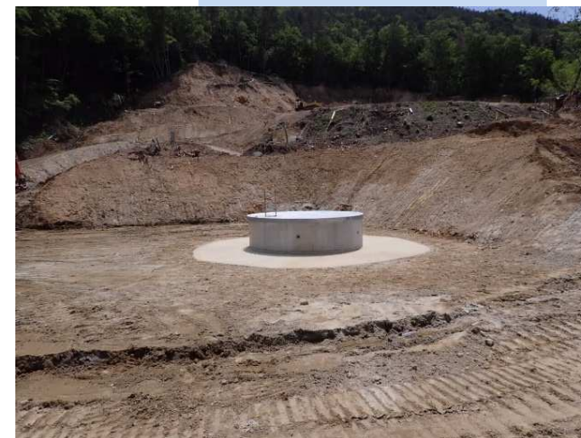
集水ボーリング施工状況
