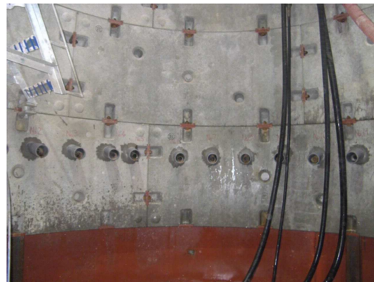
水抜きパイプから湧水の状況
