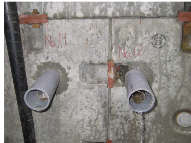
水抜きパイプから湧水の状況
