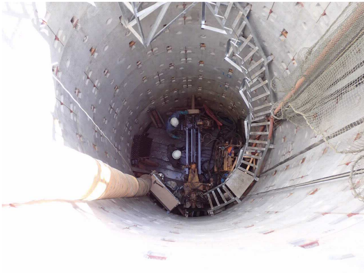
集水ボーリング施工状況
