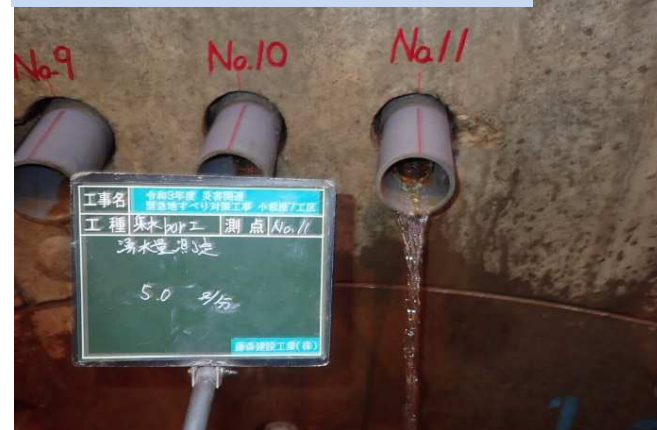
水抜きパイプから湧水の状況
