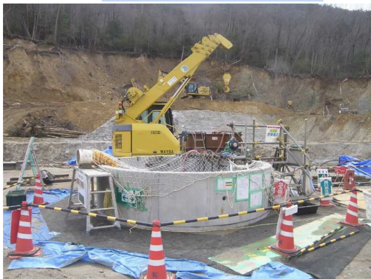
集水ボーリング施工状況
