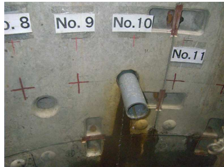
水抜きパイプから湧水の状況
