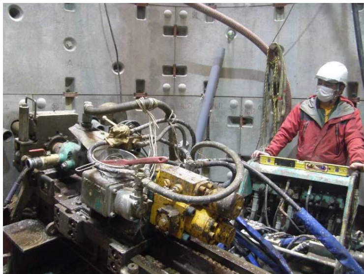
集水ボーリング施工状況
