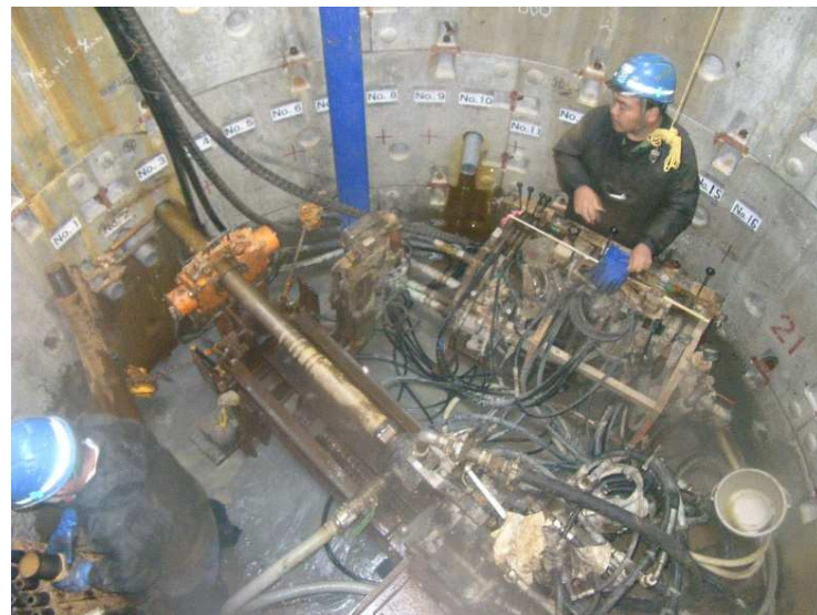
集水ボーリング施工状況
