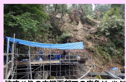
地すべりの末端下部での応急ホ-リング
