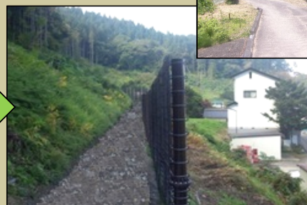
崩壊土砂防止柵 H=3.0~4.0m L=385m
