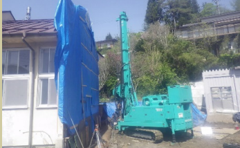
鋼管杭を8本打ち込みました
