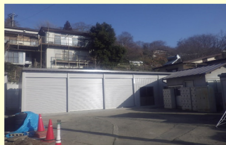
新設された車庫倉庫
