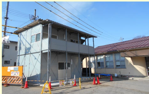
仮倉庫と事務所
