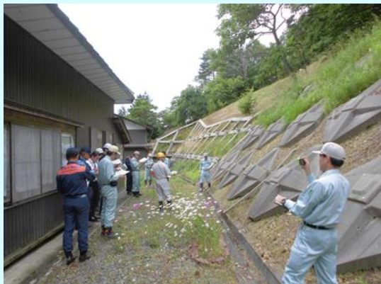
地すべり防止施設
