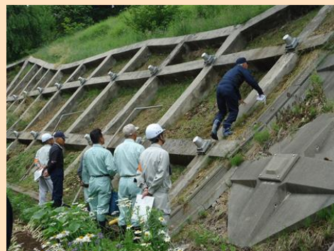
既存砂防施設の点検
