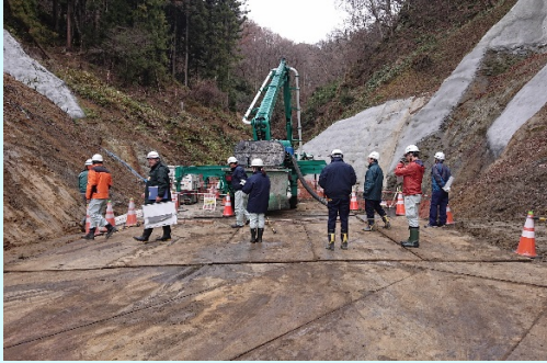
長野市大岡の砂防堰堤工事
