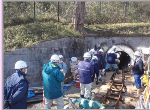
作業工程の確認
