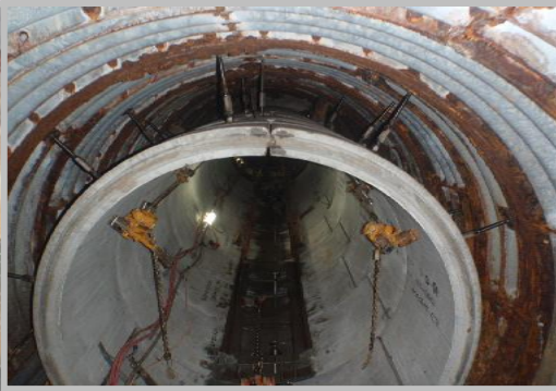
浮上防止装置取付
