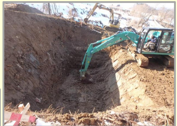
溪流路の基礎掘削
