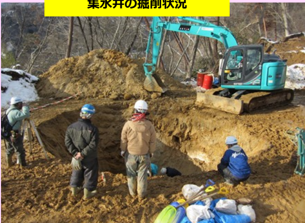
集水井の掘削状況
