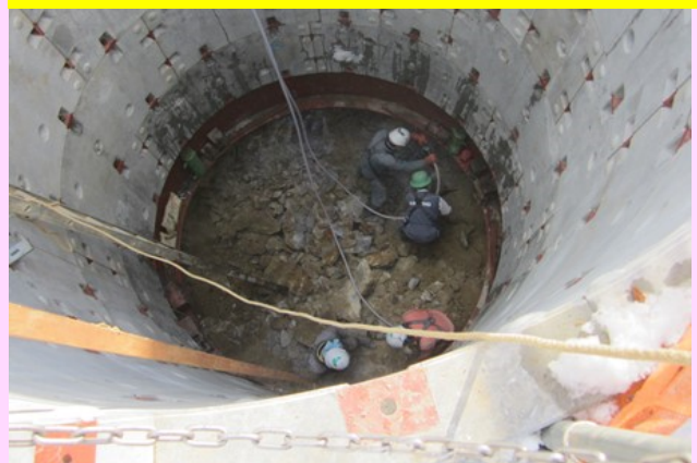
集水井内部の作業状況 RCセグメント使用
