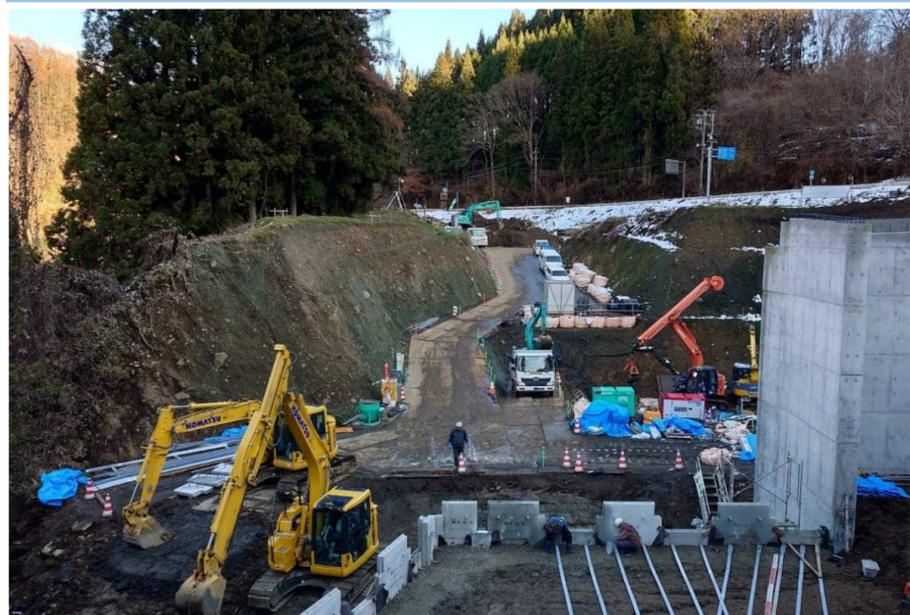
道路基礎部の擁壁が完成。その上部に補強土壁（コンクリートパネルと土砂を利用した盛土）を施工しています
