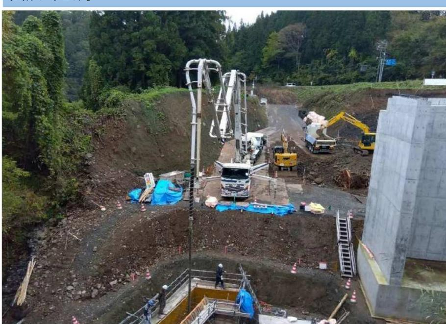
現道と橋梁をつなぐ区間において、道路の基礎となるコンクリート擁壁を施工しています
