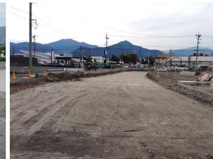
終点側 路床安定処理工 (道路の地盤を固めて強くしています)
