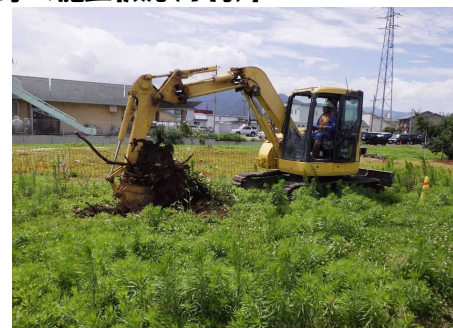
伐根状況 (木の根を取り除いています)
