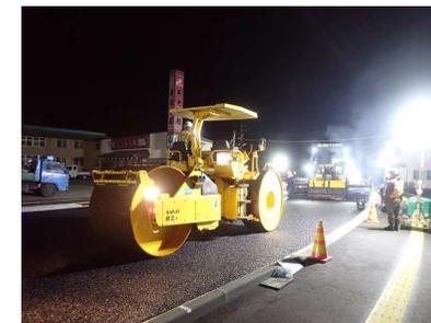
落合橋入口交差点付近 表層工夜間工事
