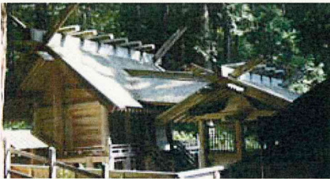
にしなしみめいぐう 仁科神明宮 (国宝:大町市) 本殿・中門(前殿) - 江戸時代中期建築
