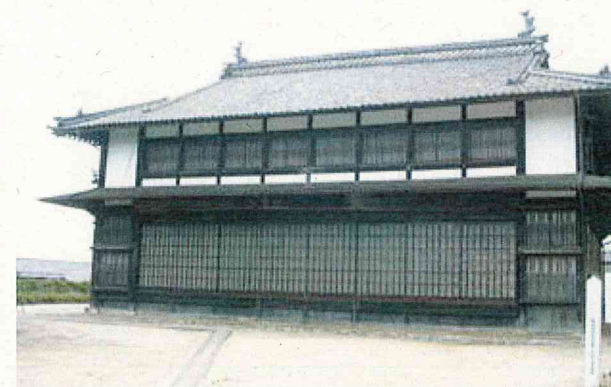
きゆうざこうじおみながつこうこうしや 旧座光寺麻績学校校舎 (県宝:飯田市) 明治6年(1873年)建築 小学校校舎でありながら1階は歌舞伎舞台として造られました。
