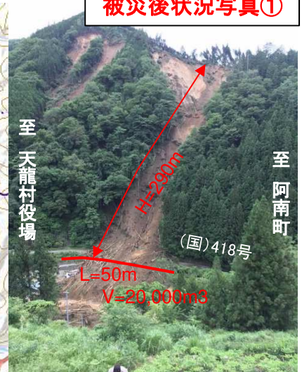
被災後状況写真①
