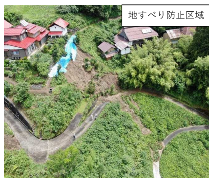
人家 1戸（住民へ注意喚起）、空家 3戸
