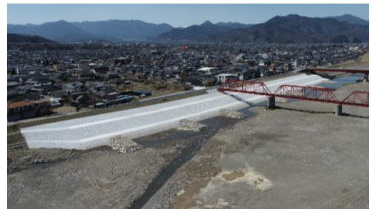
上田市諏訪形 河岸欠損工事の様子 (提供：国土交通省千曲川河川事務所)
