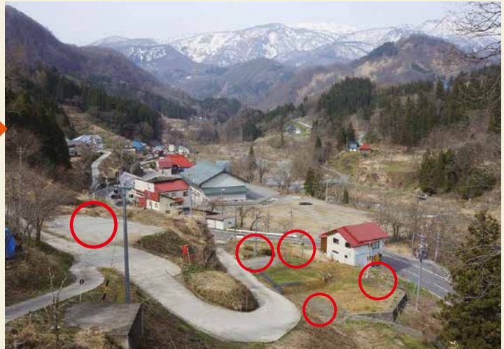
被災後、家屋10棟が取り壊された長崎集落
