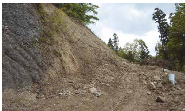
道路わきで土砂崩れが発生した林道黒川線
