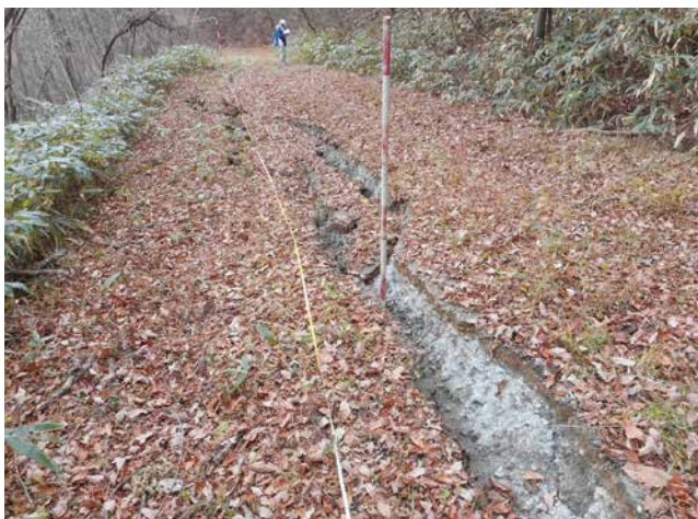
各所で地割れや路肩崩落が発生した林道大山線
