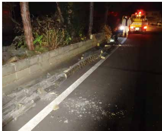
倒壊したブロック塀（水穴地区）
