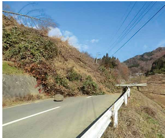
のり面が崩れて土砂にふさがれた市道（戸隠地区）
