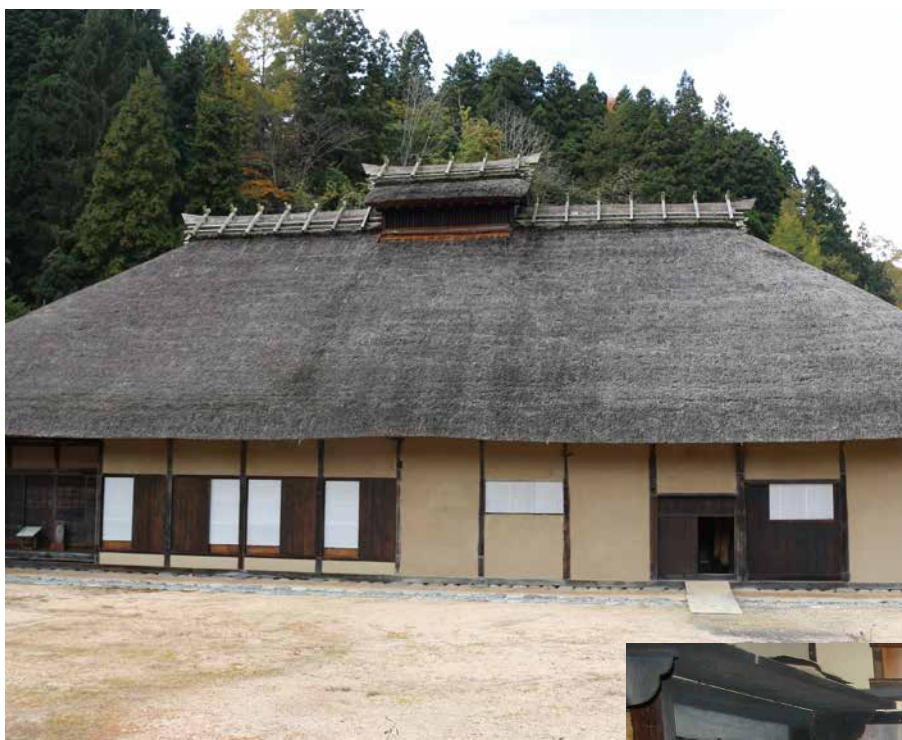
修復保存工事が完了した旧中村家住宅
