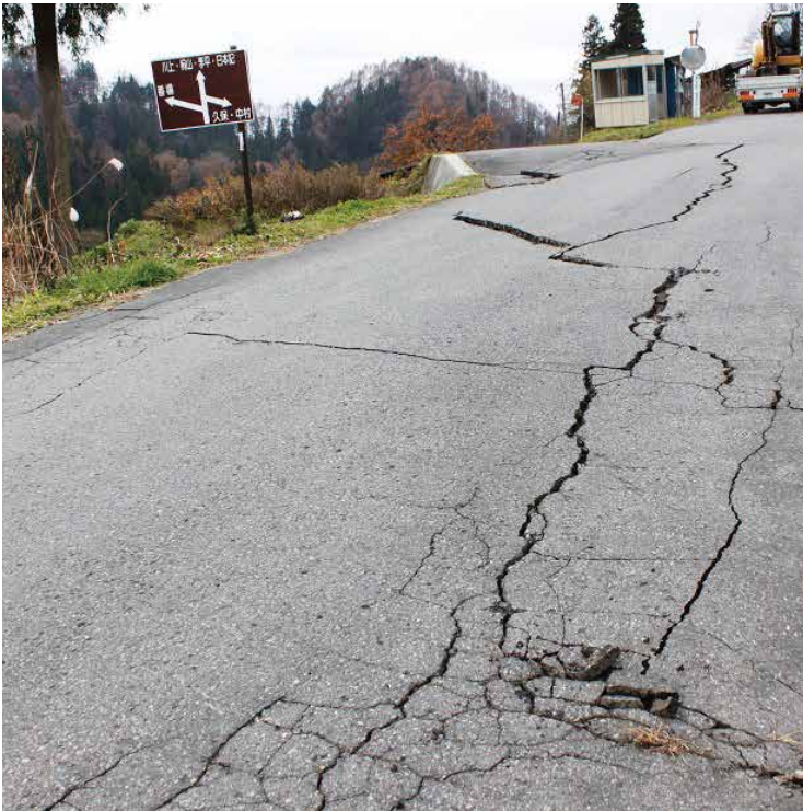
法地(瀬戸川)では村道に大きな亀裂
