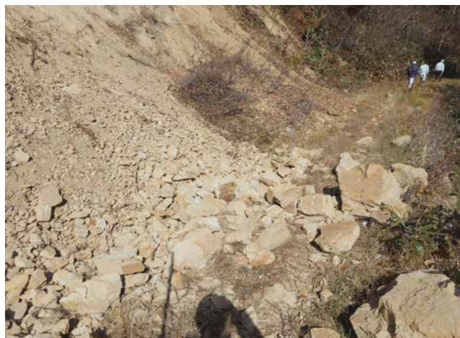
林道大山線の土砂崩落。同路線の被害箇所は23か所に上り、通行止めが解除されたのは平成27年10月
