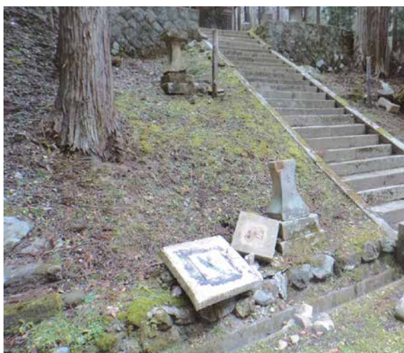
石灯籠が破損した水上神社。同神社では、市指定文化財の本殿で躯体部や基礎などに修理を要する被害が発生
