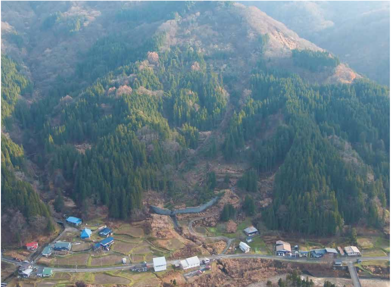
カクレ沢地すべりの全体像。設置されていた鋼製柱の砂防堰堤が土砂の流出を防止
