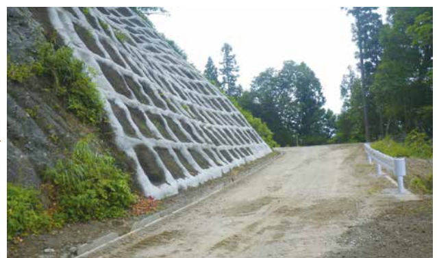
復旧に併せのり面工事も実施
