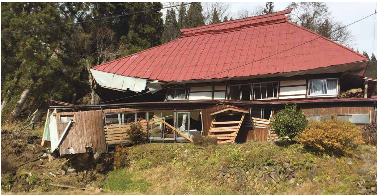
建物に達した崩落土砂(八方岩集落)
