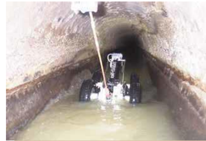
下水道管渠のテレビカメラ調査
