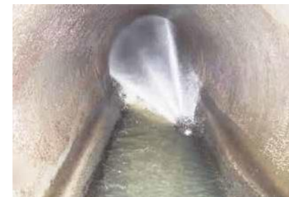
テレビカメラ調査前の管渠内洗浄
