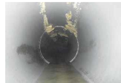
下水道管渠内の付着物 清掃後
