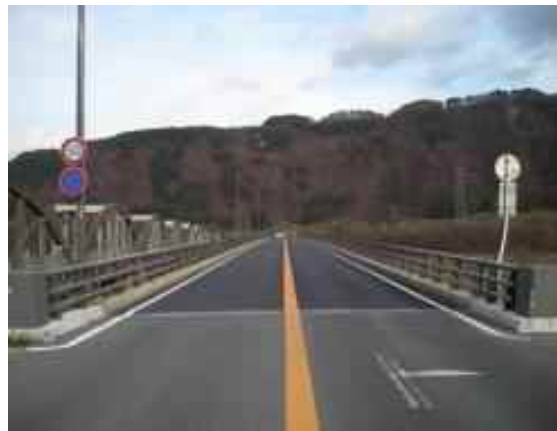
橋梁補修 田沢橋 (舗装補修後)
