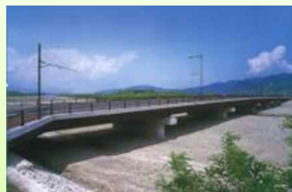
H12年5月 高瀬橋架替完成
