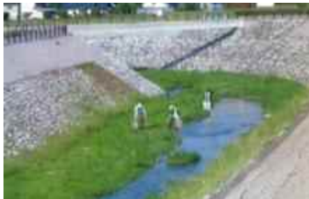
あづみの排水路の維持管理(ごみ拾い)
