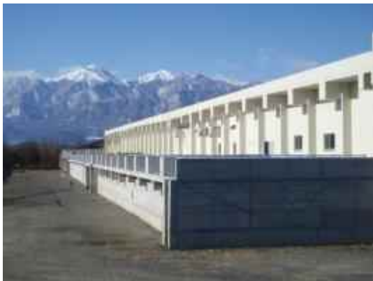
犀川安曇野流域下水道安曇野終末処理場 水処理施設第5系列完成 (H27年度には覆蓋工事が完成)
