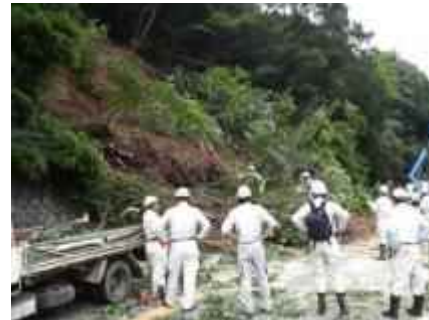
(地) 高萩地区での地すべり 国道143号が2日間通行止めとなった。
