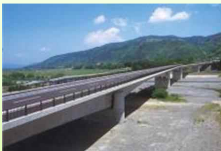
H13年1月 光橋工区供用開始
