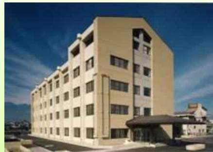
昭和 62 年 11 月 安曇野庁舎竣工
