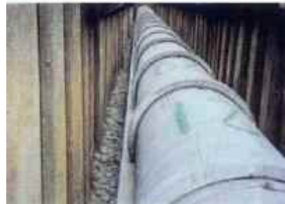
流域下水道幹線管渠の施工
