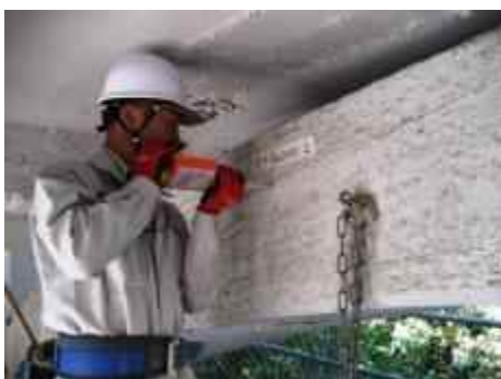
橋梁点検の様子 (信濃坂橋)
