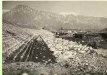
昭和 26 年 4 月 穂高川 中小河川改修に着手
