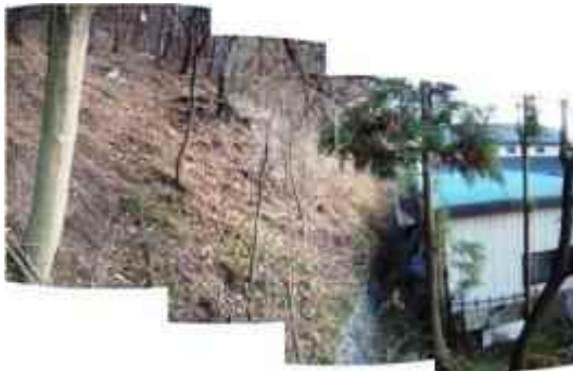
急傾斜地崩壊対策事業 桜坂小瀬幅
