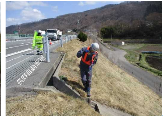
長野道上での測量(R5)
