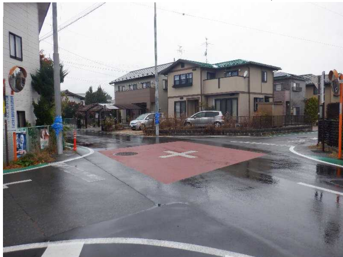
事例) 交差点部などのカラー舗装
