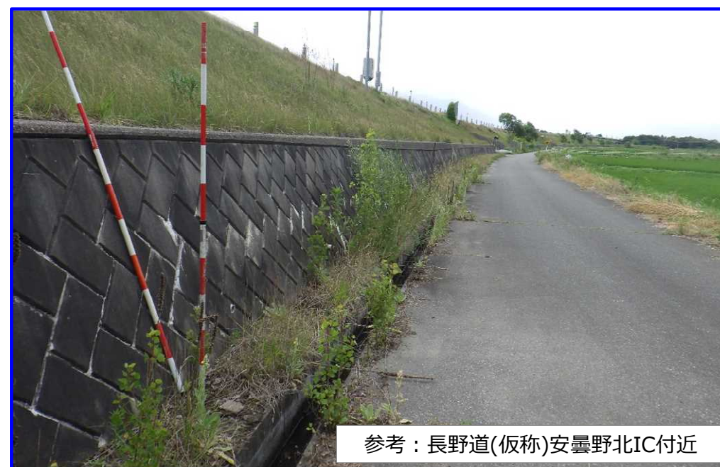
ブロック積み(写真は高さ約1.5m)
