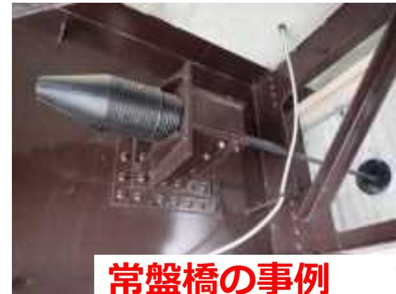
例：落橋を防止する構造
