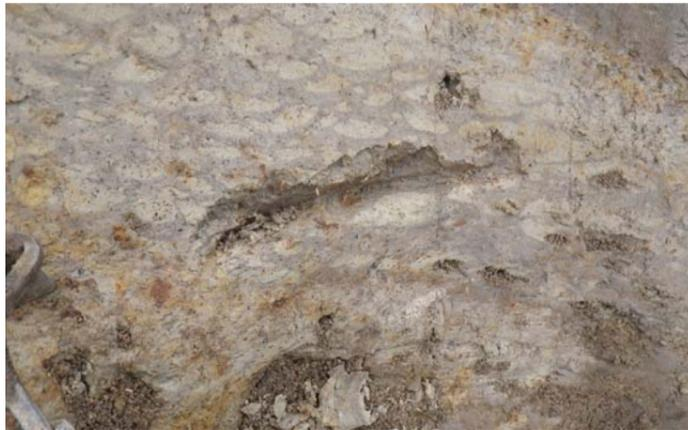
写真 5.2.58 仮排水トンネル呑口法面に、皿状構造と見られる構造が認められる。
