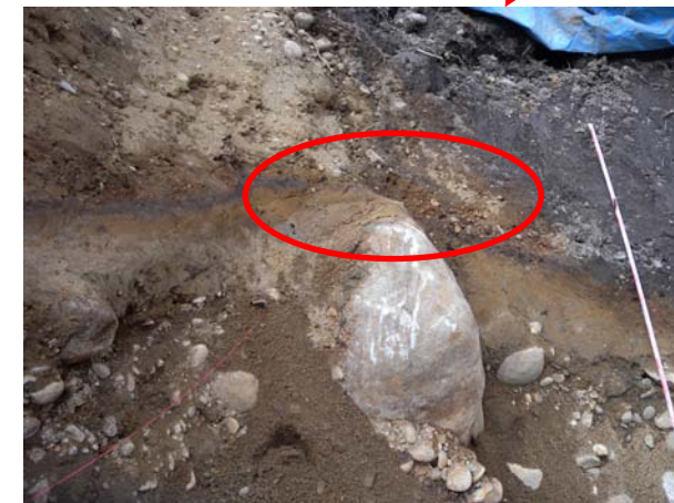
写真 5.2.3 礫に沿って有機質土層のたわみが認められる。
