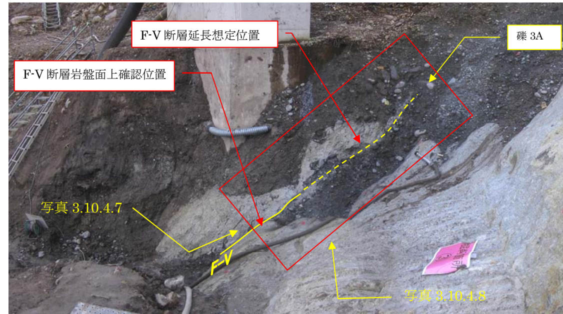
写真 3.10.3.1 トレンチ 3 の全景写真（再掲） （トレンチ 1' との連結前、灰白色軟質部追い込み調査実施前）
