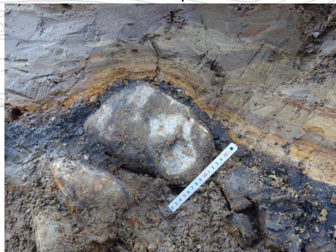
写真 5.2.24 仮排水トンネル～トレンチ6間山側法面に沿って有機質土層がたわんでいる
