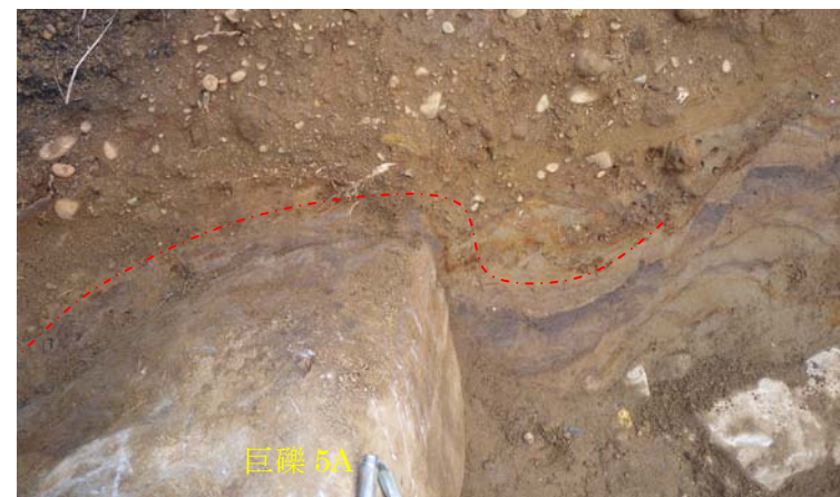
写真 5.2.5 トレンチ 5 下流壁③に見られるたわみ (巨礫の上から下流下向きに撮影)
