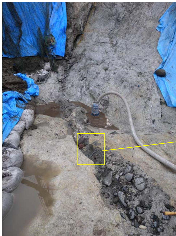
トレンチ1' とトレンチ3の連結部
