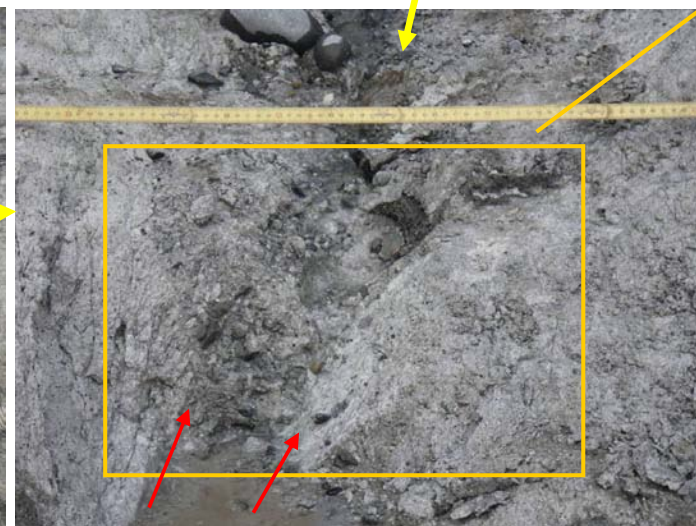
写真 3.11.4 破碎帯のクローズアップ 破碎帯の内部や上盤および下盤境界の面(赤矢印)に鏡肌や条線は確認されない。
