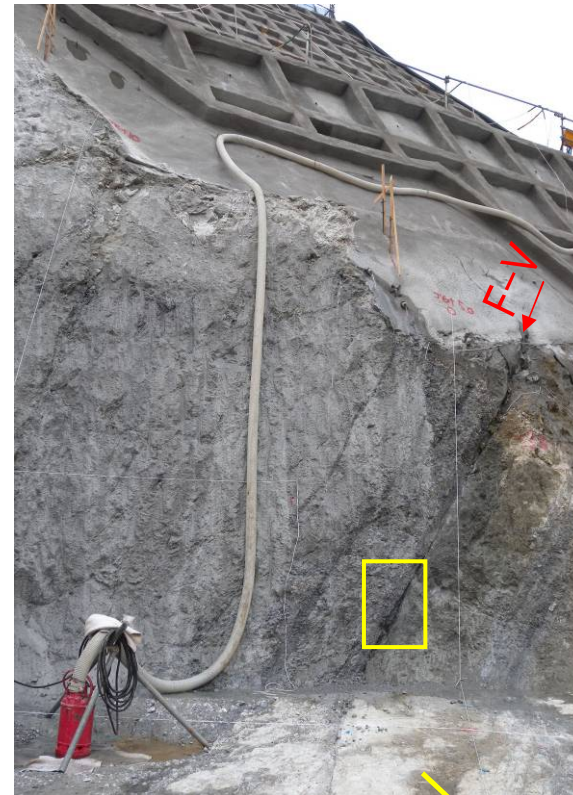
写真 5.1.23 堤敷上流端の F-V断層
