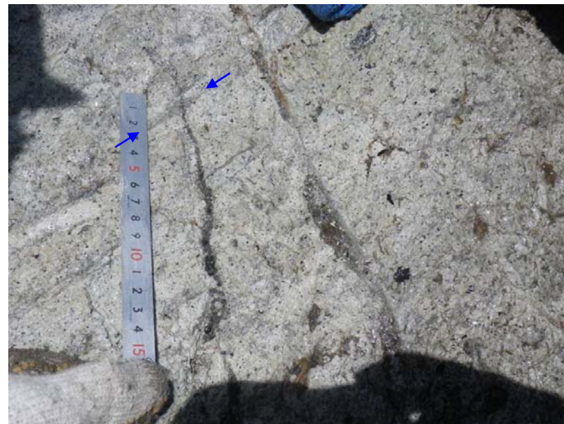
写真 5.1.22 (写真 5.1.20 青枠内クローズアップ) F-V 断層上盤側の岩盤中に見られる割れ目に砂が挟まっている状況。このような砂の挟みは連続性が乏しく、割れ目の方向は様々で一定せず、割れ目に沿う変位はない。(青色矢印部分)
