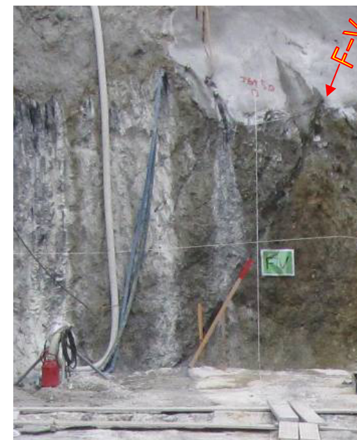
写真 3.1.2.4 堤敷上流端付近の F-V 断層 左写真：平成 23 年 9 月露出（右写真）。断層破碎帯（粘土化帯～粘土混じり細片化帯）は流出しているが、断層面は明瞭で自立している。断層粘土は数 cm 程度。左写真は平成 23 年 11 月 9 日撮影。
