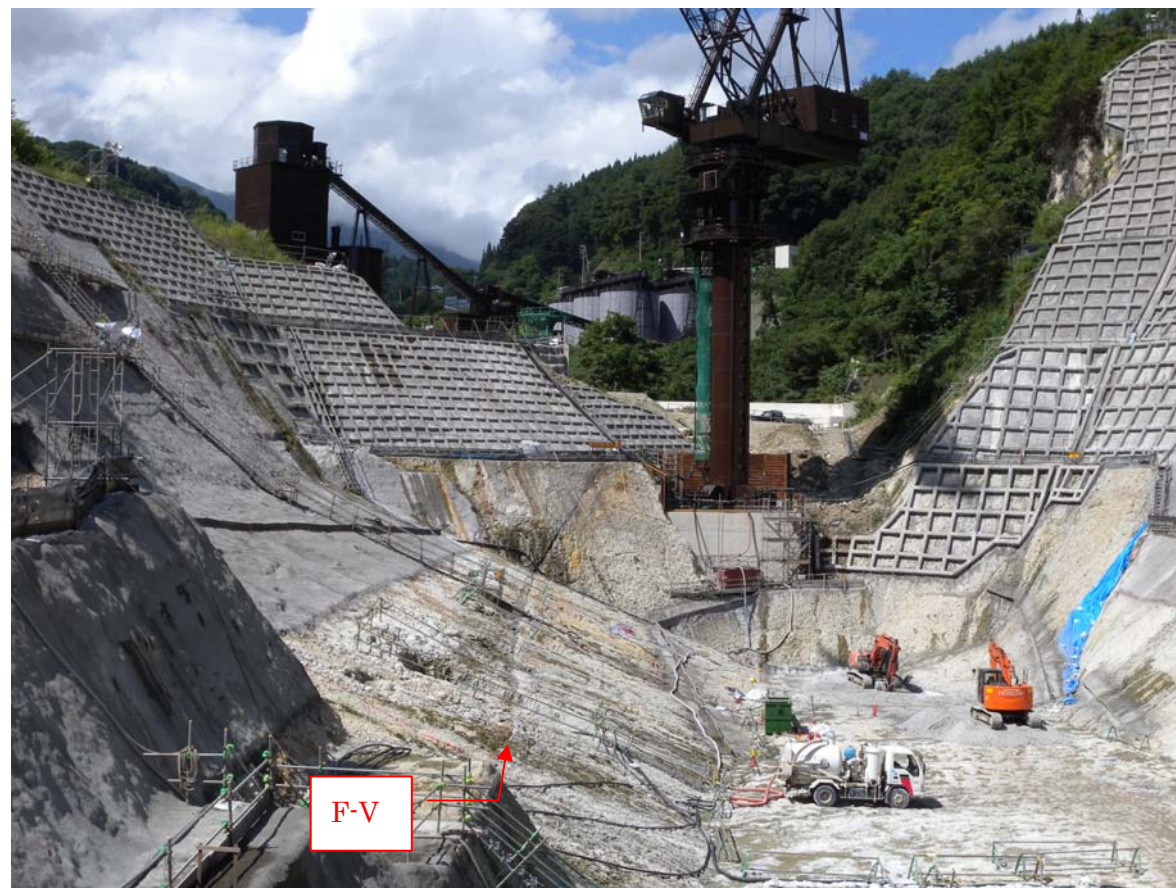
写真 1.1.1 ダムサイト右岸を上下流方向に伸びる F-V 断層
