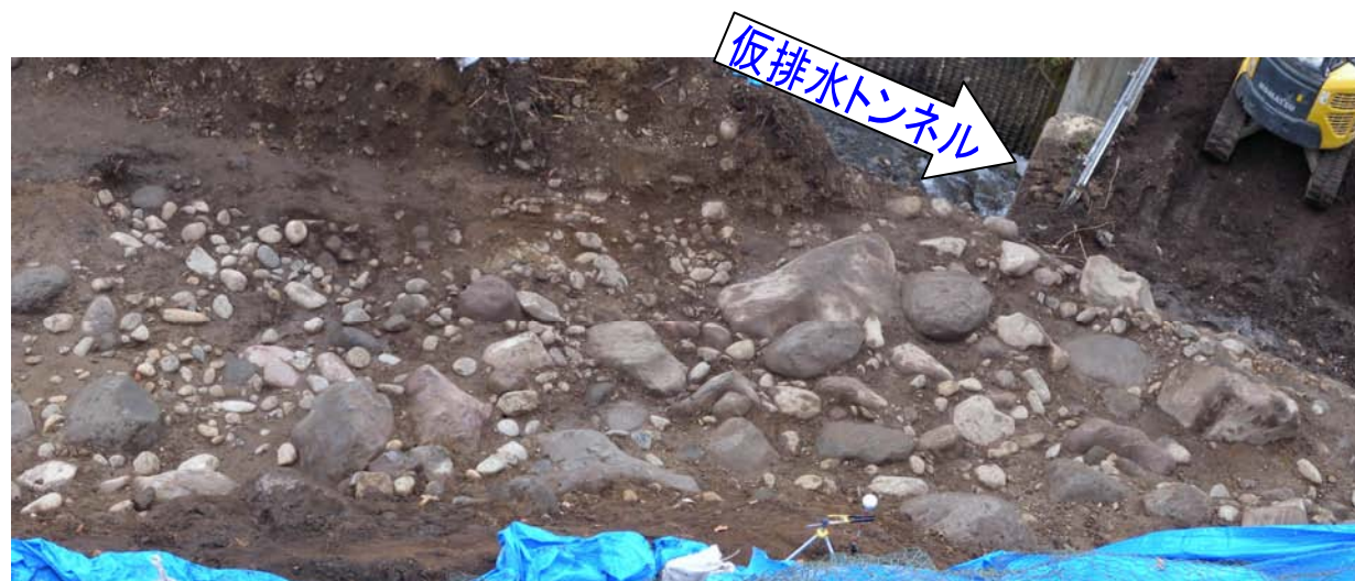
写真 2.1.2.1 仮排水トンネル呑口～トレンチ6 古流向調査実施状況
