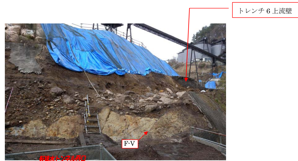
写真3.4.4.1 仮排水トンネル呑口～トレンチ6の岩盤面上における礫の配列調査全景（砂礫の頭を出した状態を下流から望む）
