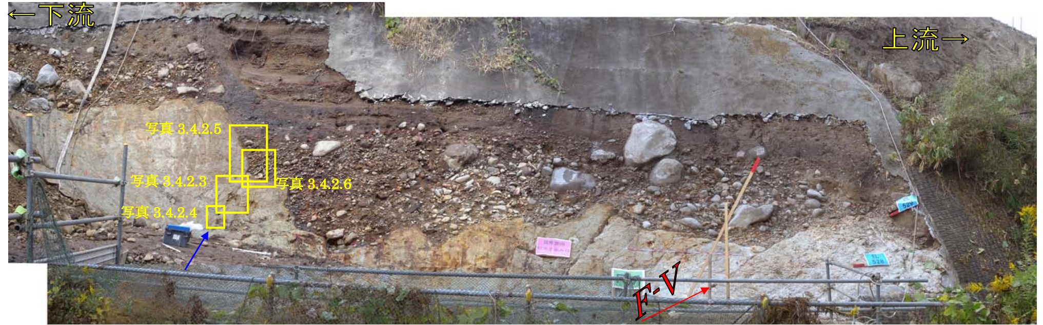
写真 3.4.2.2 仮排水トンネル呑口法面全景
