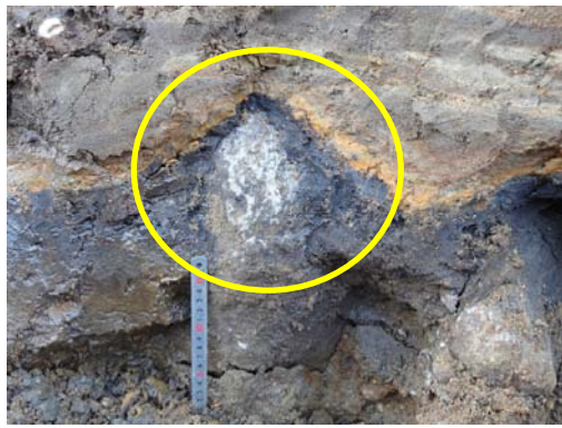
写真 3.4.1.2(1) 礫の上位の有機質土層等に生じているたわみ
