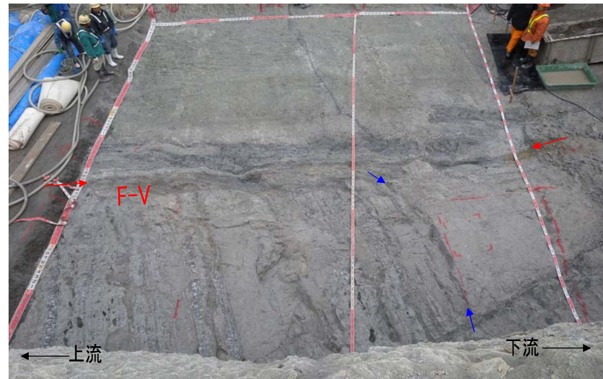
写真 1.1.3 F-V 断層処理工底盤に現れた F-V 断層に伴う地層の引きずり (ダムサイト右岸、ダム軸下流 9.5m～ダム軸下流 18.5m、赤矢印が F-V 断層、青矢印は引きずられた地層の一つを例示。)
