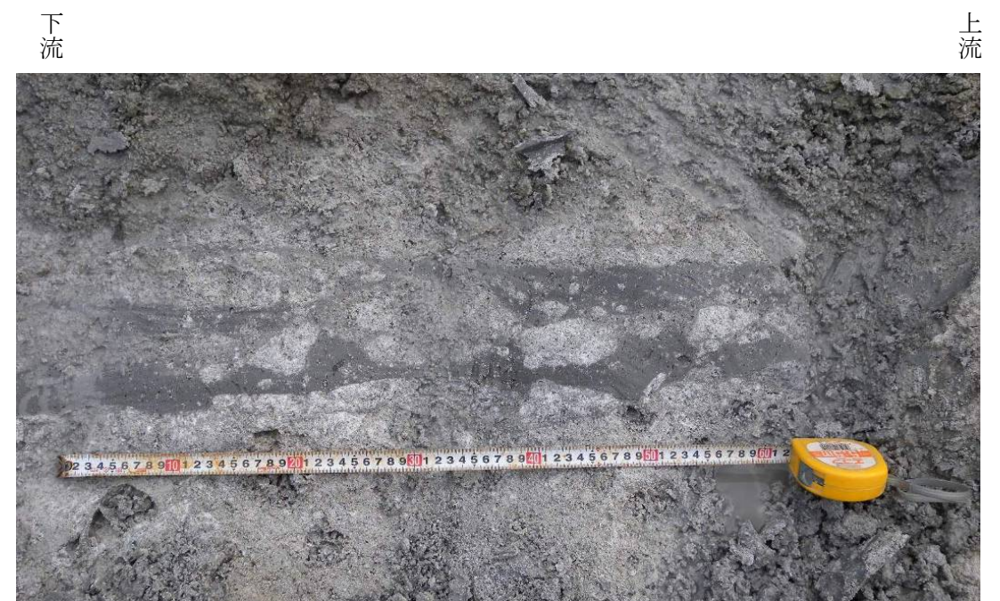
図 3.1.2.7 ダム基礎岩盤における F-V 断層の位置
