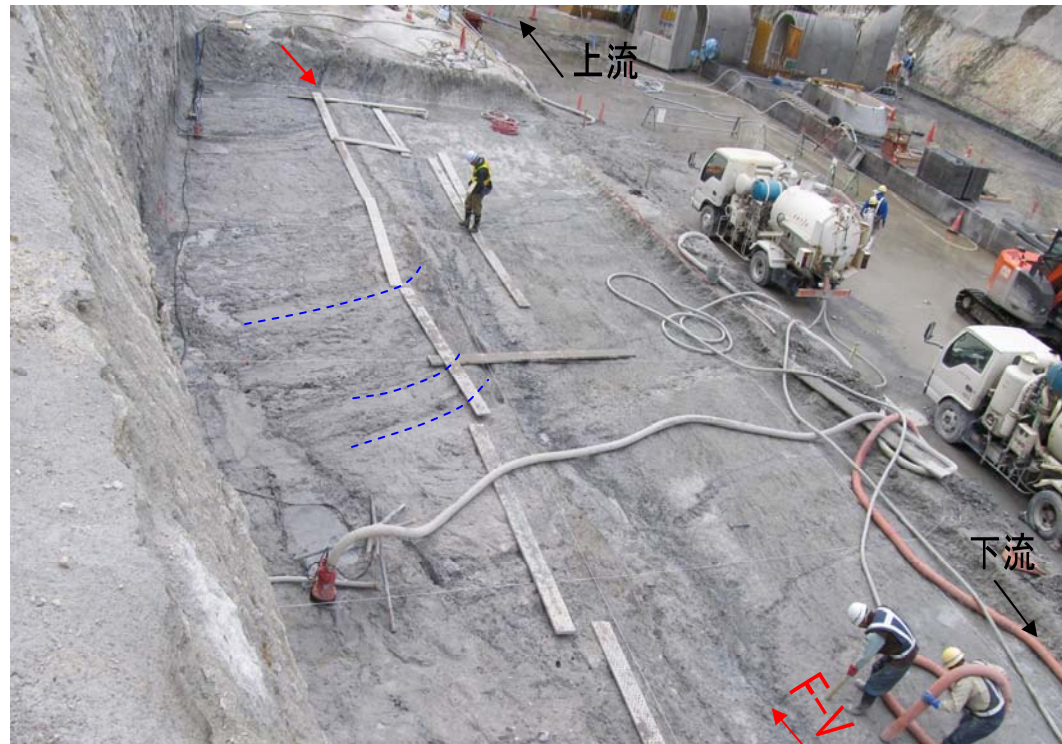
写真 1.1.2 F-V 断層処理工底盤に現れた F-V 断層に伴う地層の引きずり (ダムサイト右岸、ダム軸～ダム軸下流 25m、青破線は引きずられた地層の形を例示)
