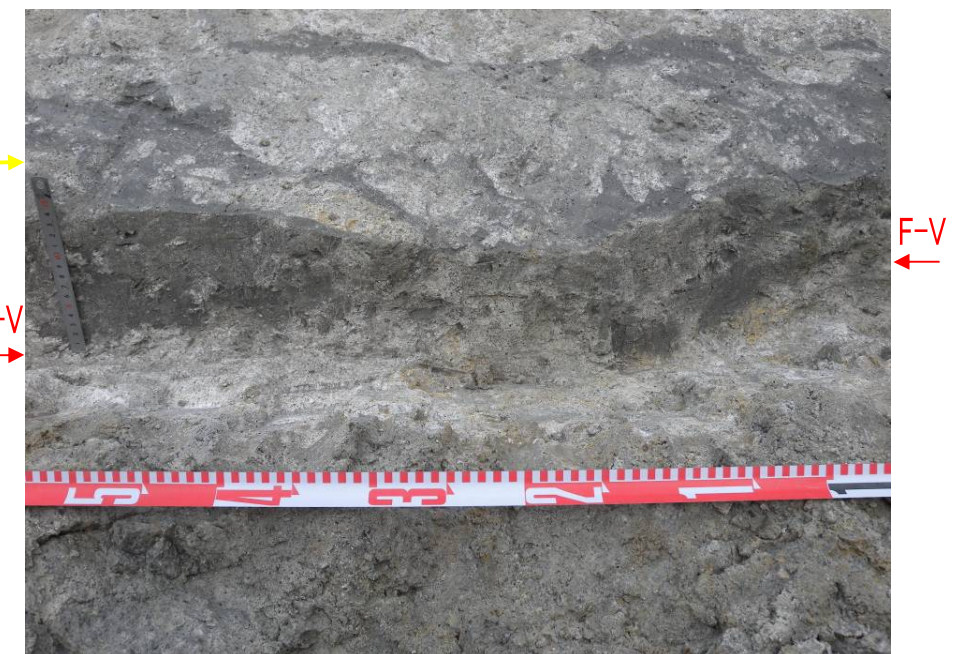
写真 3.1.2.10 写真 3.1.2.9 のクローズアップ 粘土化帯と周辺岩盤の境界は漸移的に変わる。
