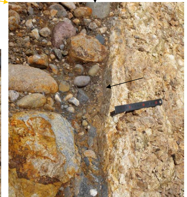
写真 3.4.3.6 F-V 断層に落ち込んでいる砂礫断層面 (矢印部) に擦痕は確認されない。
