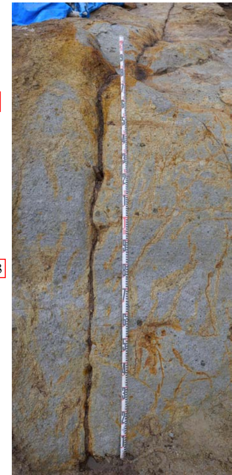
写真 3.4.5.8 仮排水トンネル側法面に現れている F-V 断層以外の開口割れ目。幅最大 3cm 程度の細礫混じり砂を挟む。(12 月撮影)
