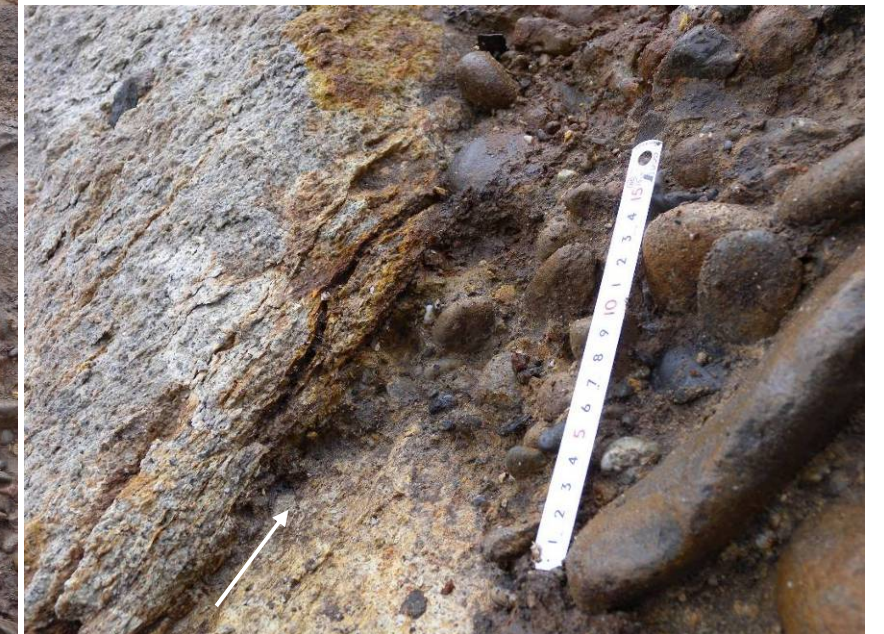
写真 3.4.2.6 砂礫層と基盤岩の境界に沿って破碎は認められない。
