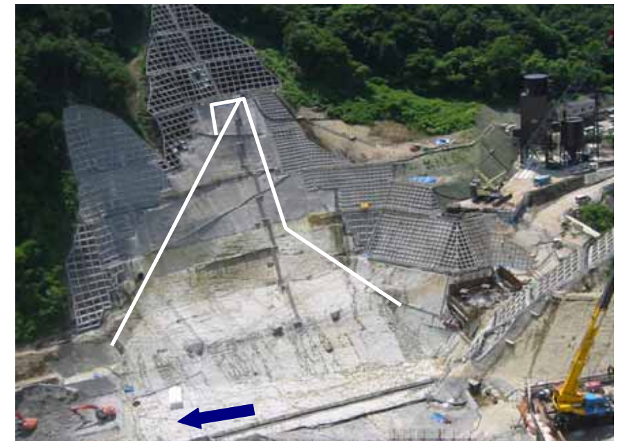
写真5 ダム右岸側の状況
