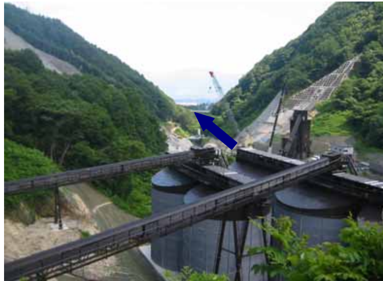
写真2 CSG押え盛土（転流工）の状況
