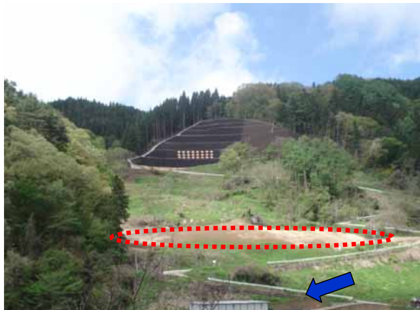
写真① R-2 ブロック (頭部排土工)
