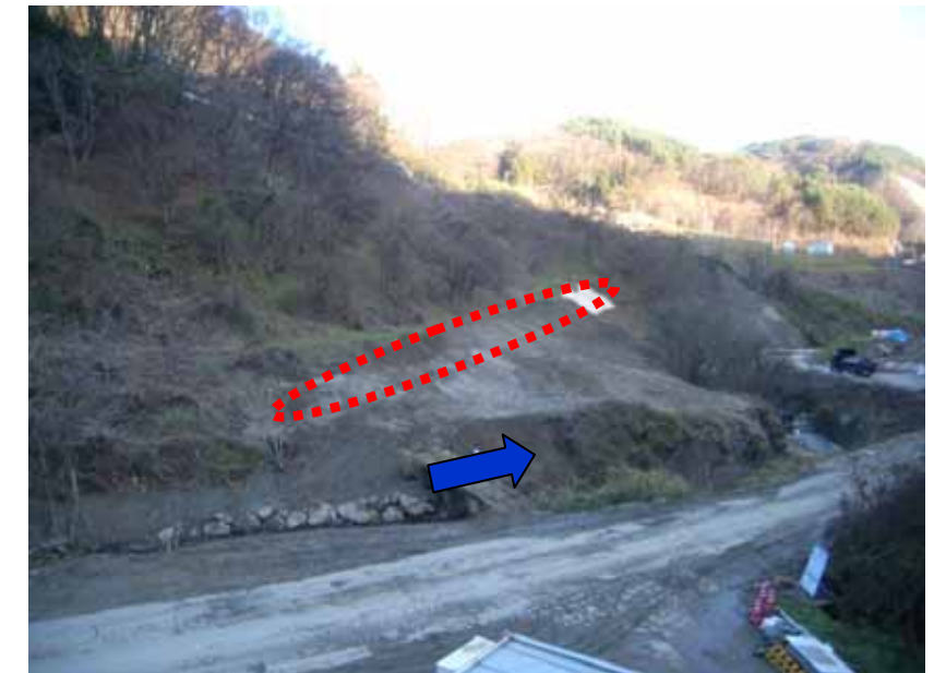
写真③ L-2 c ブロック (鋼管杭工)
