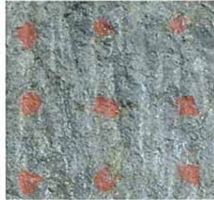
高圧水による水洗
