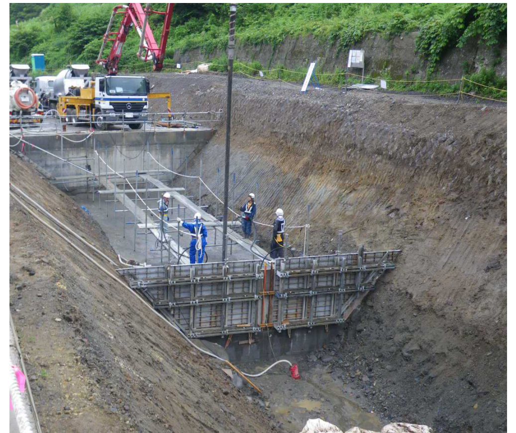
図 3.6.4 置換コンクリート施工状況写真
