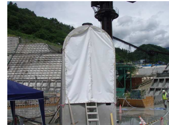
写真 3.4.17 監査廊入口ファスナーシート設置
