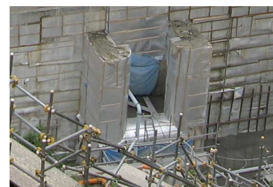
写真 3.4.23 B ダム 堤内仮排水路 ブルーシート養生状況
