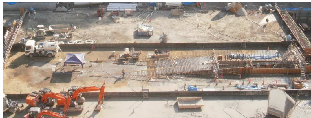
写真 3.4.19 常用洪水吐き部の打設状況(H24 年 6 月 26 日撮影)
