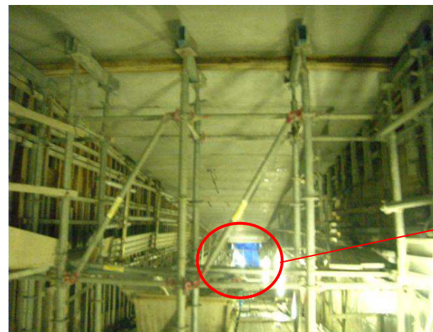
写真 3.4.20 型枠存置養生(写真奥は吐口ブルーシート養生)
