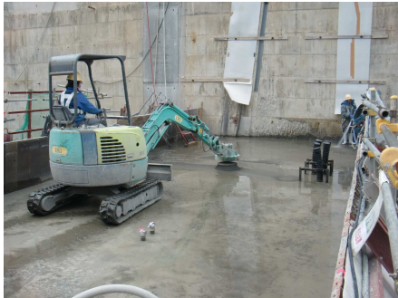
写真 3.4.4 GC マシンによる二次カット
