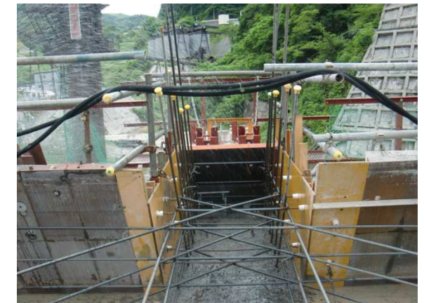
写真 3.4.16 スクリーン部の散水養生
