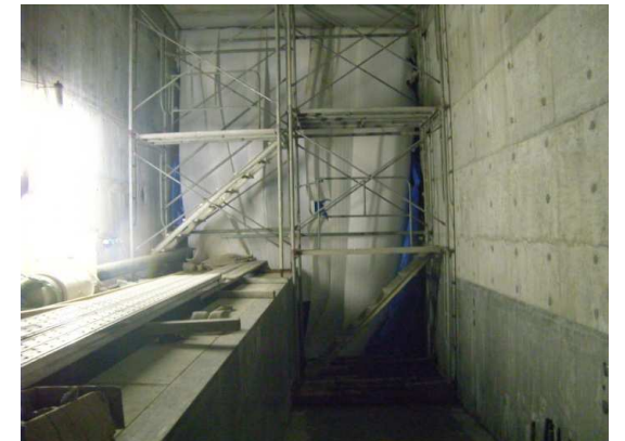
写真 3.4.26 下流吐口部断熱マット t=10mm 追加
