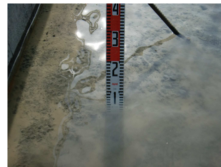
写真 3.4.10 湛水養生の水深確認
