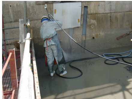
写真 3.4.7 止水板付近の二次カット
