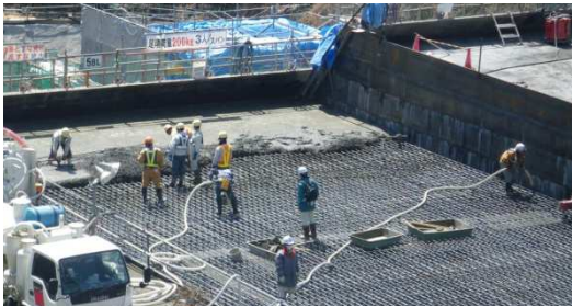
写真 3.4.35 平成 24 年越冬面配筋施工状況
