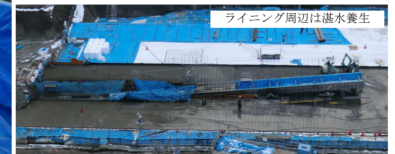
写真 3.4.18 ライニングの養生(断熱マット(t=10mm)+ブルーシート)
