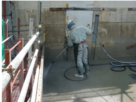
写真 3.4.5 高圧水による二次カット
