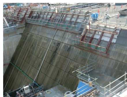
写真 3.4.13 DF 型枠の養生
