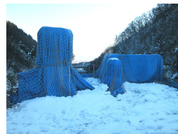
写真 3.4.31 エレベータシャフト周辺の越冬養生
