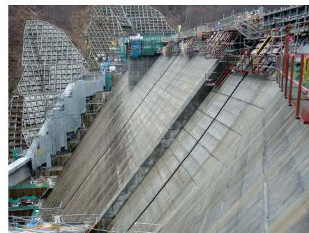
写真 3.4.11 斜面部の散水養生
