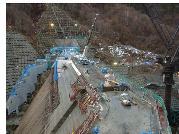
写真 3.4.29 斜面部の越冬養生施工状況
