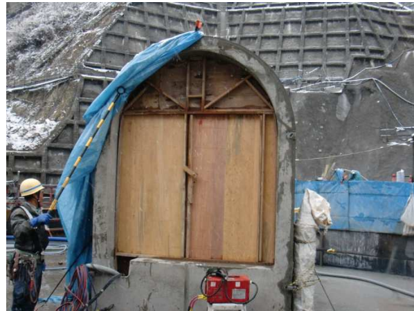
写真 3.4.33 監査廊入口扉設置(越冬養生)
