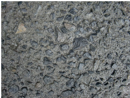
写真 3.4.6 GC マシンによる二次カット後の打設面
