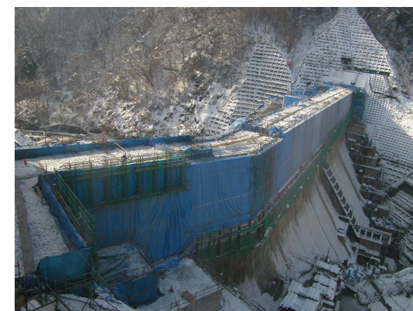
写真 3.4.27 水平打継面の越冬養生
