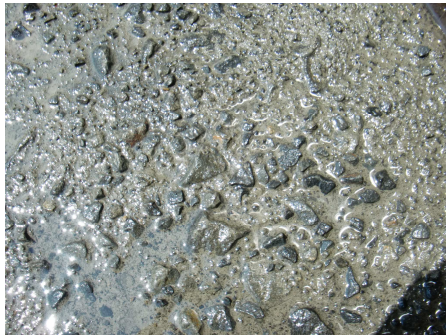
写真 3.4.3 GC マシンによる一次カット後の打設面
