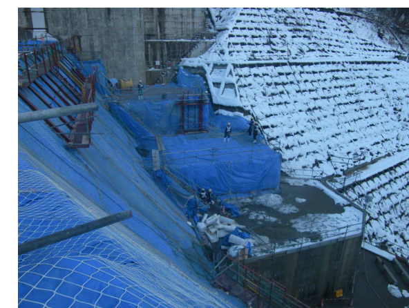
写真 3.4.30 7-チング部の越冬養生
