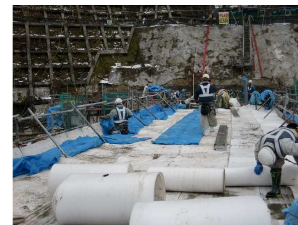
写真 3.4.28 水平打継面の越冬養生施工状況
