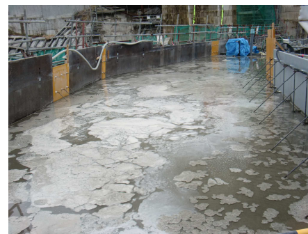
写真 3.4.9 湛水養生写真
