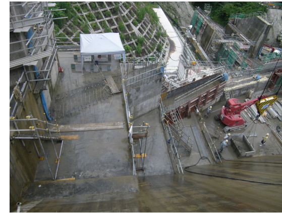
写真 3.4.15 導流壁部の散水養生
