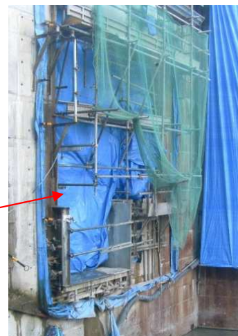
写真 3.4.21 下流吐口部シート養生
