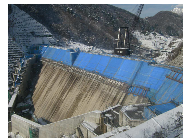
写真 3.4.32 下流面の越冬養生
