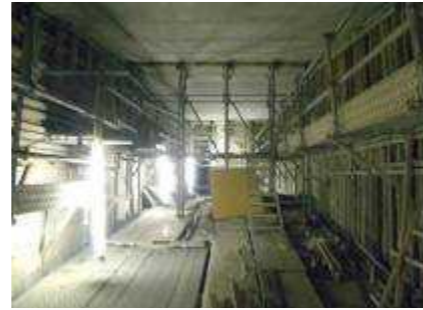
クラック発見前の洪水吐き内部の状況（型枠はH23年度越冬面より下の部分では既に撤去したものがあつたが、それ以外は全て存置されていた）
