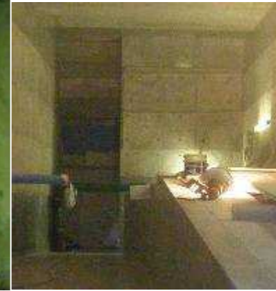
(施工中) 写真 3.4.25 上流呑口部断熱マット t=10mm 追加
