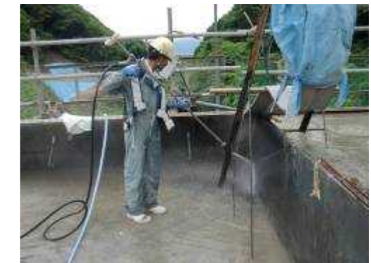
写真 3.4.7 止水板付近の二次カット
