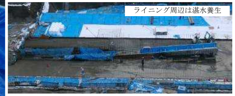
写真 3.4.18 ライニングの養生(断熱マット(t=10mm)+ブルーシート)
