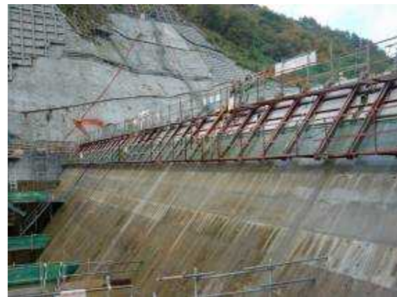
写真 3.4.11 斜面部の散水養生
