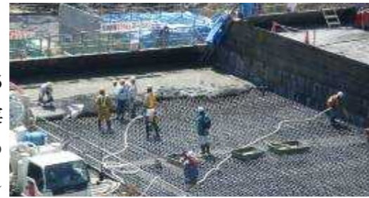
写真 3.4.35 平成 24 年越冬面配筋施工状況
