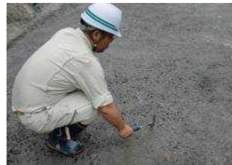
写真 3.4.3-2 GC状況の確認検査
