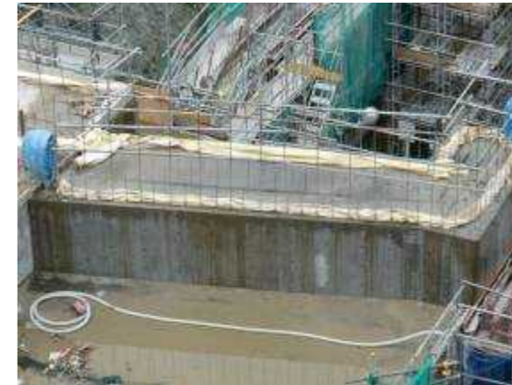
写真 3.4.15 導流壁部の散水養生
