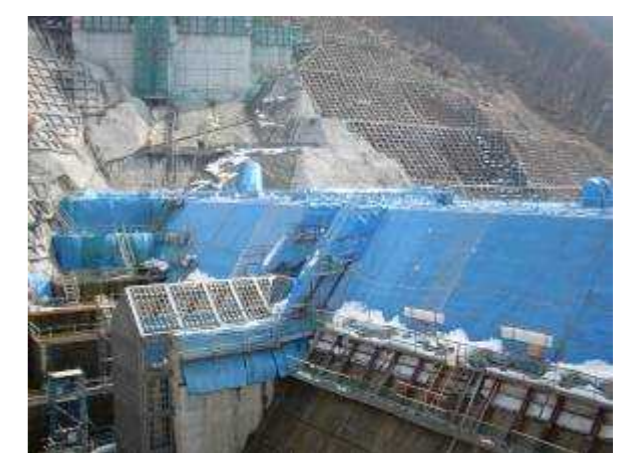
写真 3.4.30 スクリーン部の越冬養生
