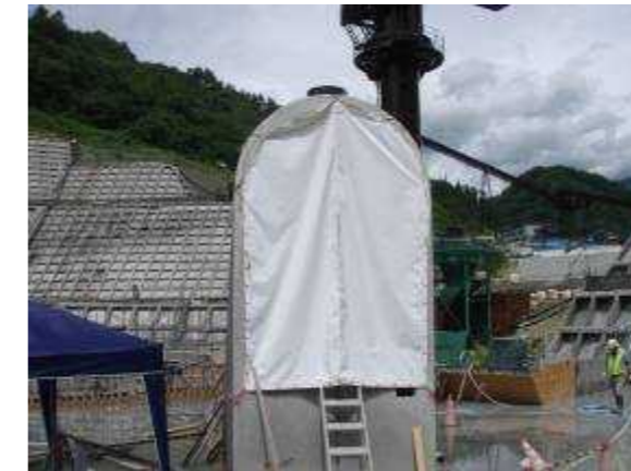
写真 3.4.17 監査廊入口ファスナーシート設置
