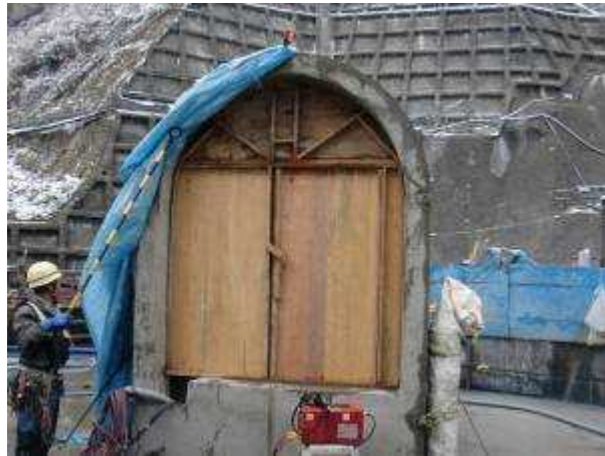
写真 3.4.33 監査廊入口扉設置(越冬養生)
