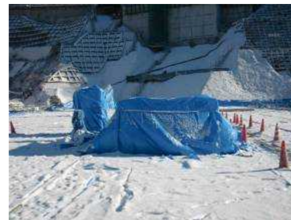
写真 3.4.31 エレベーターシャフト周辺の越冬養生
