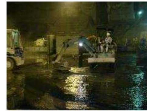
写真 3.4.4 GCマシンによる二次カット
