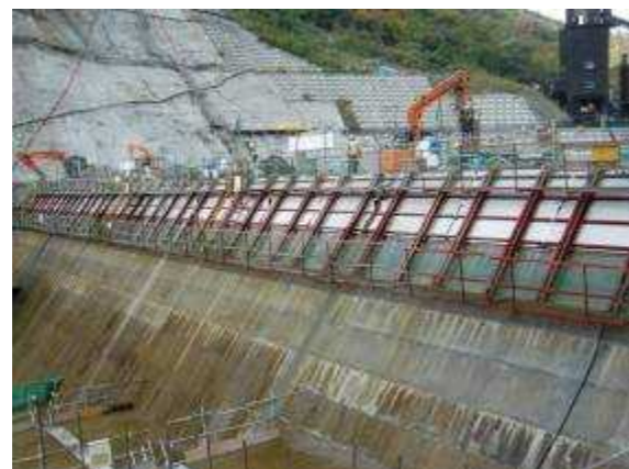
写真 3.4.13 DF型枠の養生
