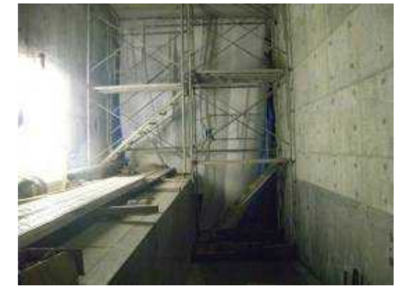
写真 3.4.26 下流吐口部断熱マット t=10mm 追加
