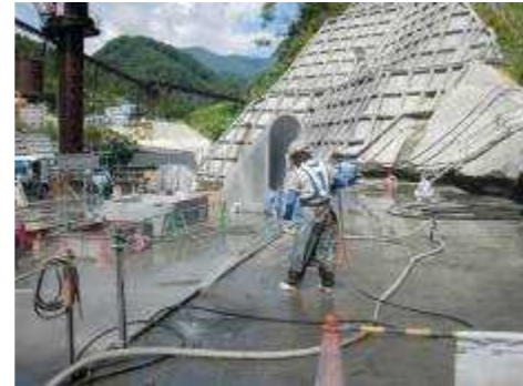
写真 3.4.2 高圧水による一次カット
