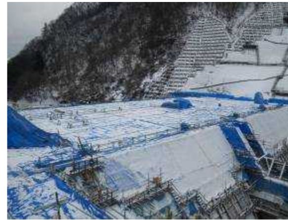
写真 3.4.27 水平打継面の越冬養生
