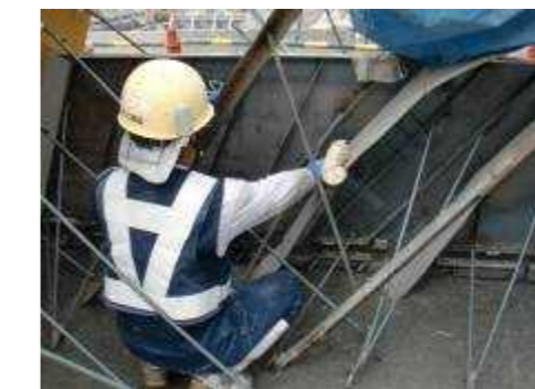
写真 3.4.8 止水板の清掃
