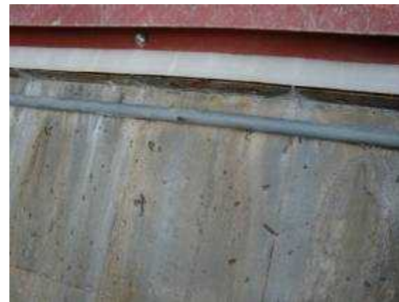
写真 3.4.12 斜面部の散水養生
