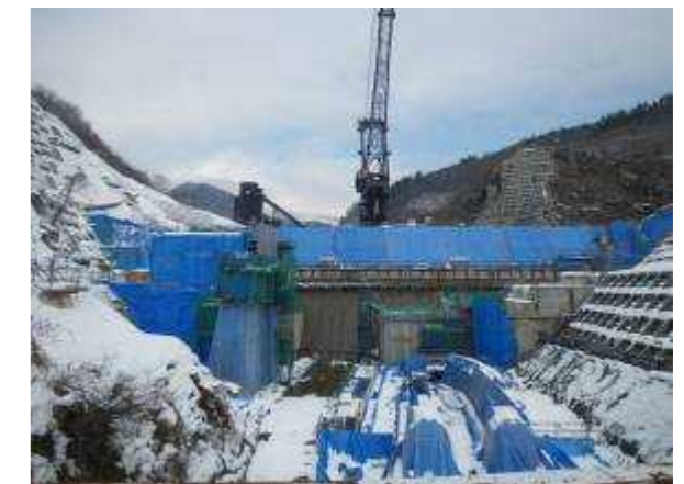
写真 3.4.32 下流面の越冬養生
