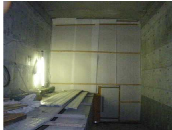
写真 3.4.34 下流吐口部木製扉+断熱マット+ブルーシート
