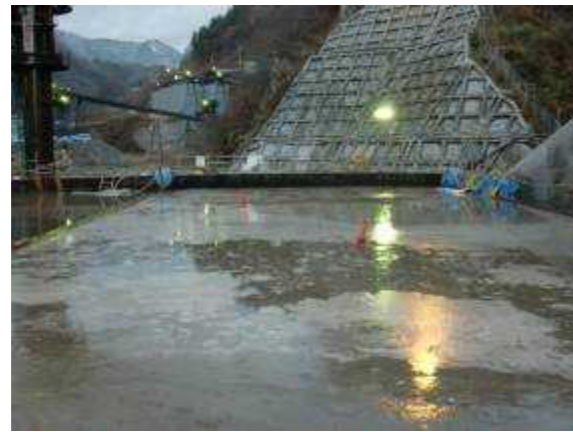
写真 3.4.9 湛水養生写真
