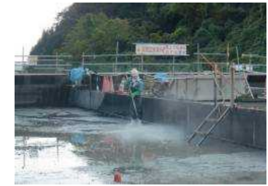
写真 3.4.5 高圧水による二次カット
