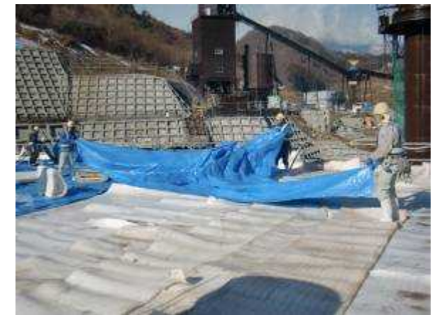
写真 3.4.28 水平打継面の越冬養生施工状況
