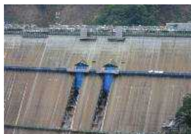
写真 3.4.22 志津見ダムコンジットゲート吐口 ブルーシート養生状況
