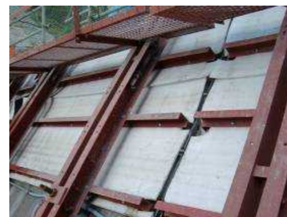
写真 3.4.14 DF型枠の養生
