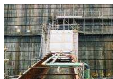
写真 3.4.24 琴川ダム 堤内排水路 防煙シート養生状況
