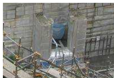
写真 3.4.23 丹生川ダム 堤内仮排水路 ブルーシート養生状況
