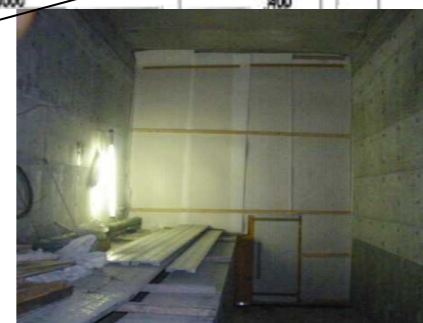
下流吐口部扉+断熱マット（t=10mm）設置
