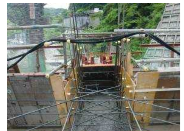
写真 3.4.16 スクリーン部の散水養生
