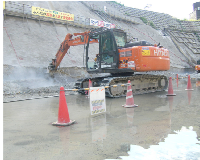
作業区画明示
