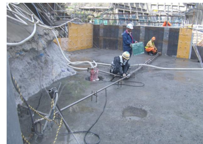
写真 参-3 水抜きパイプ布設状況
