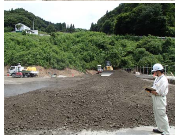
敷均し (7t 級ブルドーザ)
