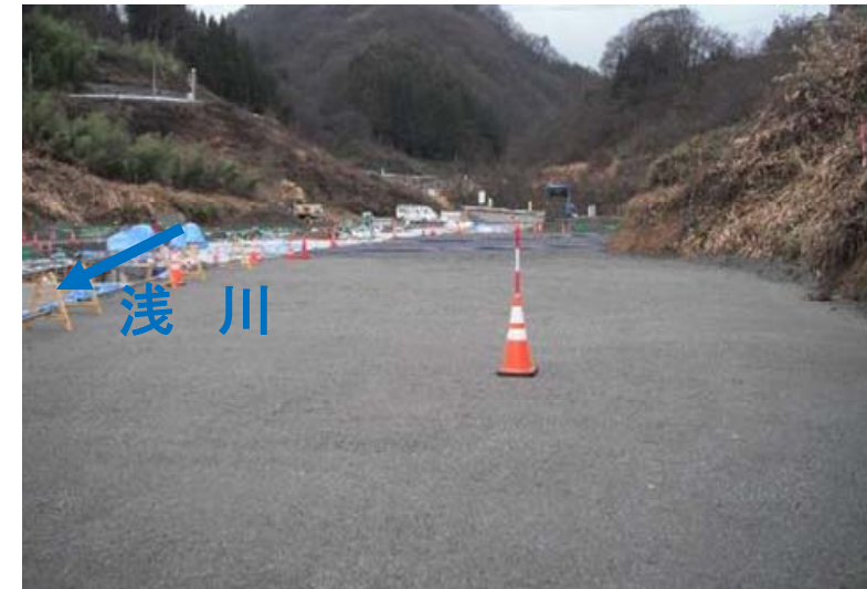
写真 3.6.9 設置位置の状況(左岸)
