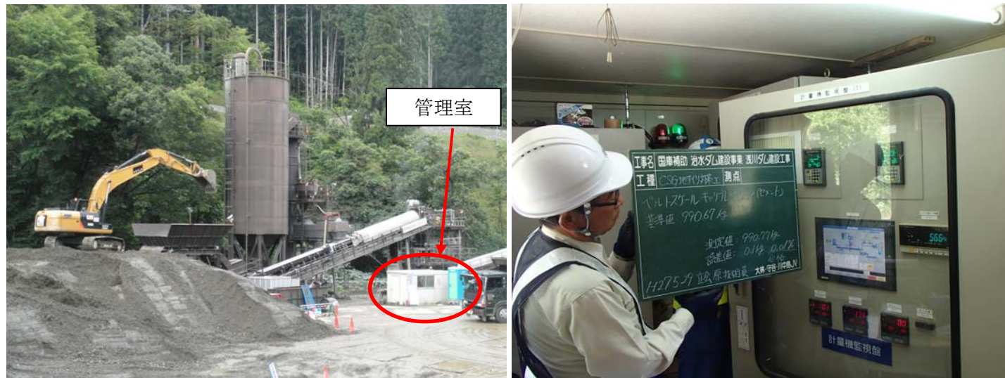
写真 3.6.7 CSG 混合機全景 (管理室)
