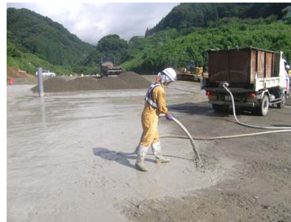
セメントペースト敷均し
