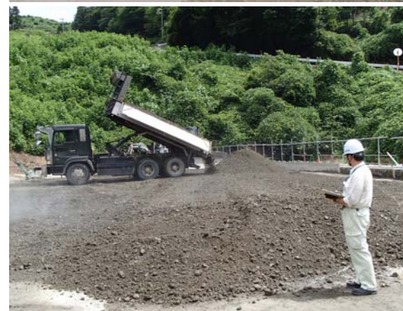
運搬 (10t ダンプトラック) 及び撤出し
