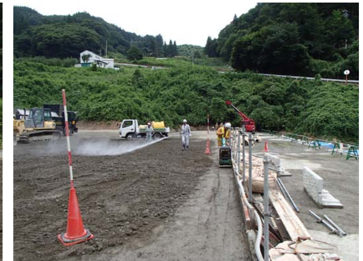
写真 3.6.4 端部転圧 (パイプロコンパクター 10回)
