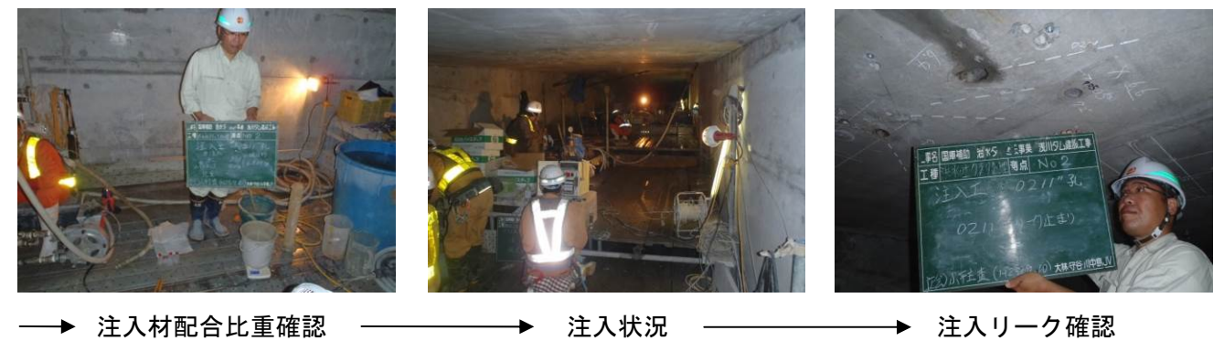
写真 3.4.36 延伸したクラックのグラウチング工施工状況
