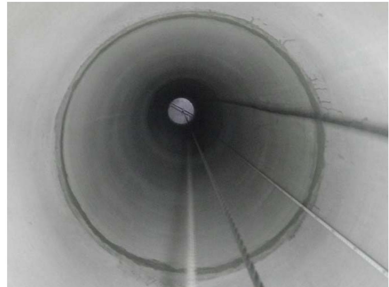
図 3.4.57 クラック補修後の状況
