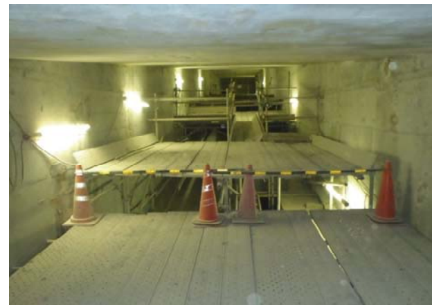
仮設備、足場の設置状況
