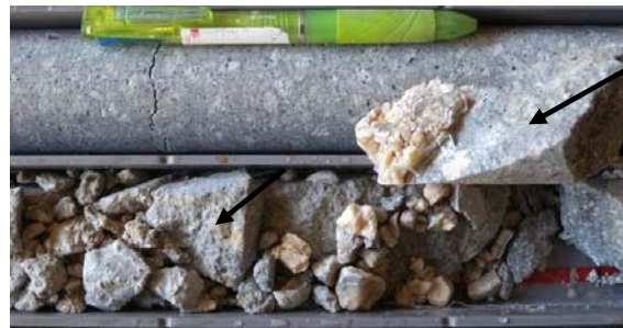
写真 3.5.1 PR7（パイロット）孔 18st に認められるかみ合わせが悪い割れ目（Lu=50.65 注入 12 回）
