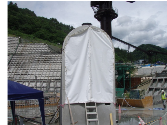
写真 3.4.17 監査廊入口ファスナーシート設置
