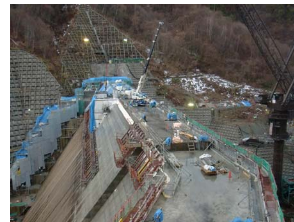
写真 3.4.29 斜面部の越冬養生施工状況
