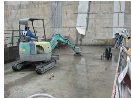
写真 3.4.4 GCマシンによる二次カット
