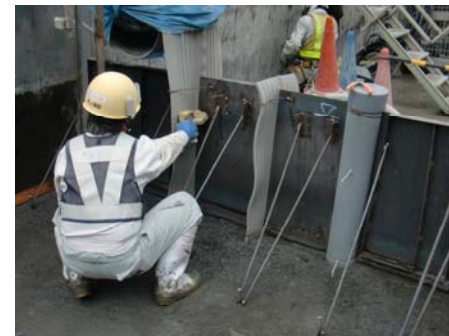
写真 3.4.8 止水板の清掃
