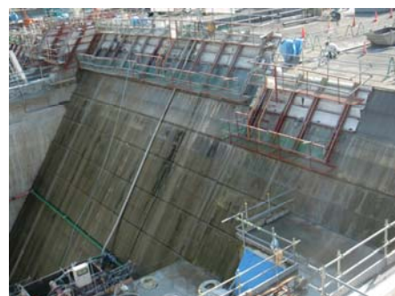
写真 3.4.13 DF 型枠の養生
