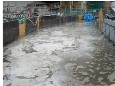
写真 3.4.9 湛水養生写真
