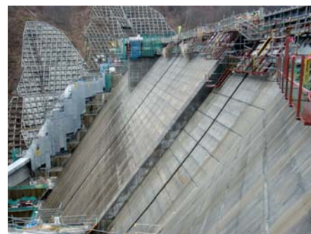
写真 3.4.11 斜面部の散水養生
