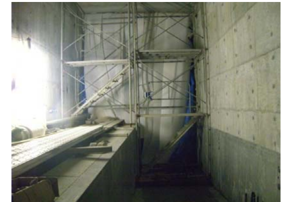
写真 3.4.25 上流呑口部断熱マット（t=10mm 追加） 写真 3.4.26 下流吐き口部断熱マット（t=10mm 追加）
