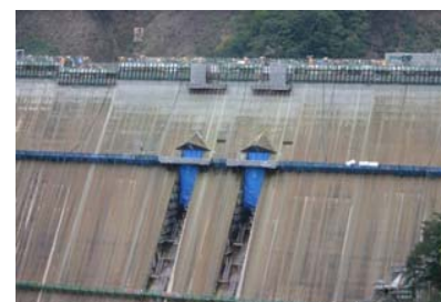
写真 3.4.22 A ダム コンジットゲート吐口 ブルーシート養生状況
