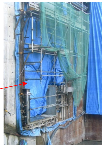
写真 3.4.21 下流吐口部シート養生
