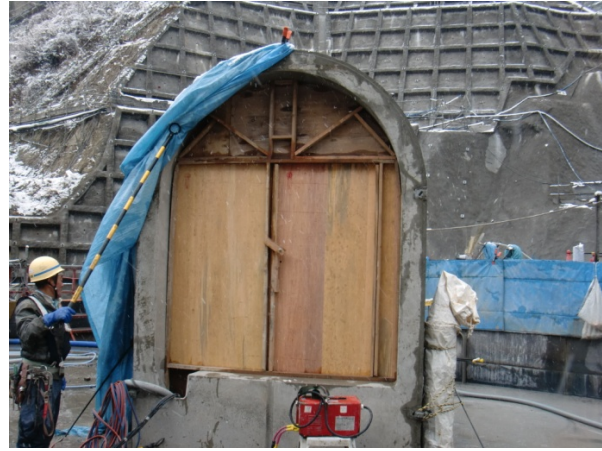
写真 3.4.33 監査廊入口扉設置 (越冬養生)
