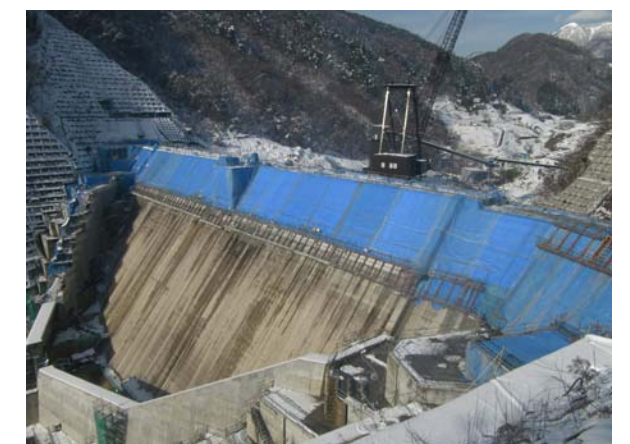
写真 3.4.32 下流面の越冬養生
