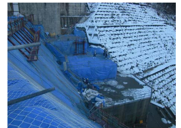
写真 3.4.30 フーチング部の越冬養生
