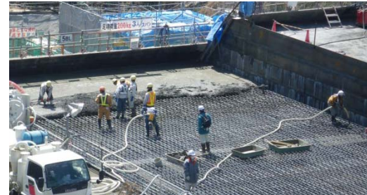
写真 3.4.35 平成 24 年越冬面配筋施工状況
