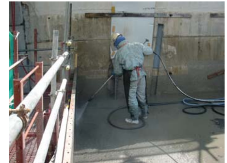
写真 3.4.5 高圧水による二次カット
