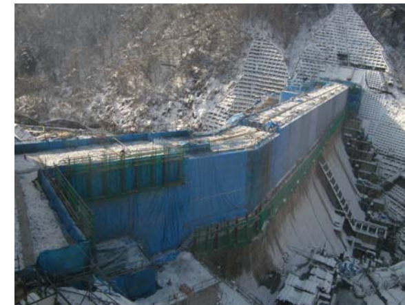
写真 3.4.27 水平打継面の越冬養生
