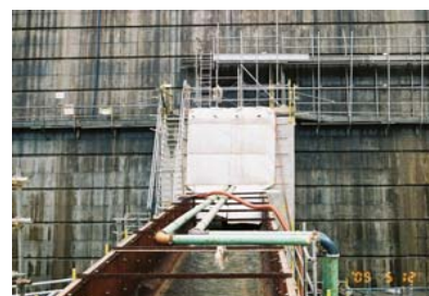
写真 3.4.24 C ダム 堤内排水路 防煙シート養生状況
