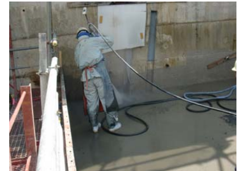
写真 3.4.7 止水板付近の二次カット
