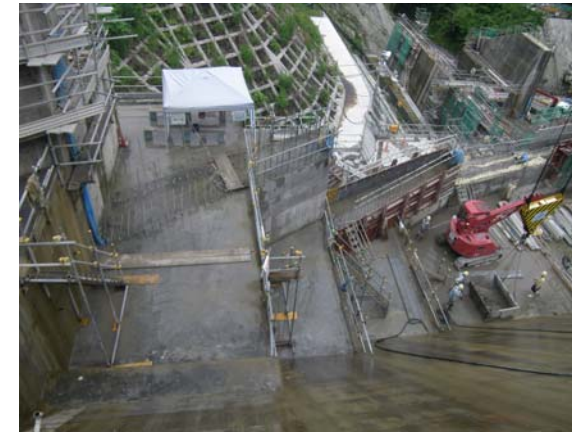
写真 3.4.15 導流壁部の散水養生
