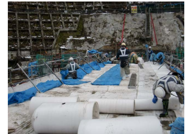
写真 3.4.28 水平打継面の越冬養生施工状況
