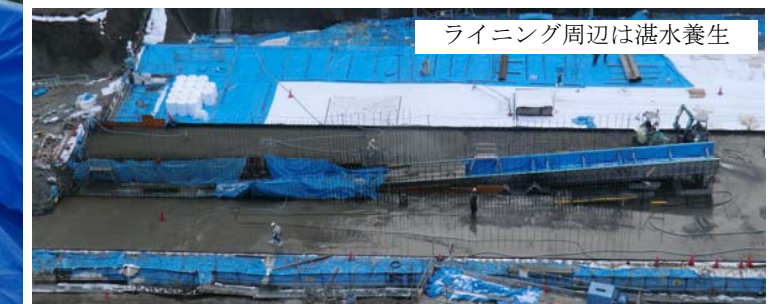
写真 3.4.18 ライニングの養生（断熱マット（ t=10\text{mm} ）+ブルーシート）
