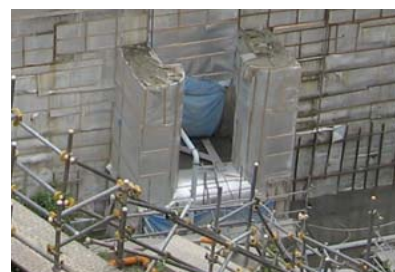
写真 3.4.23 B ダム 堤内仮排水路 ブルーシート養生状況
