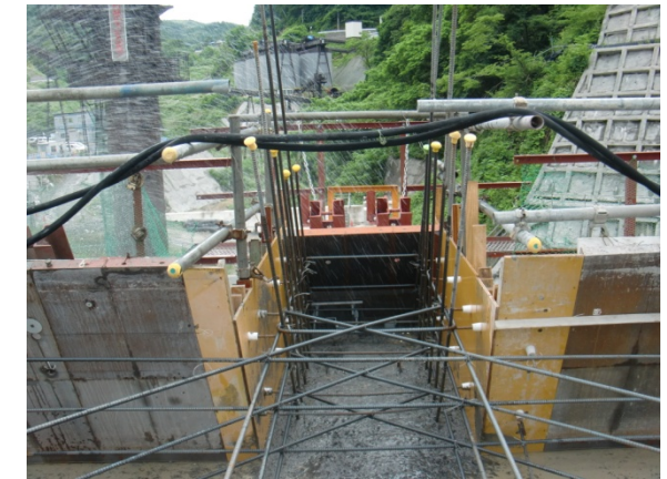
写真 3.4.16 スクリーン部の散水養生
