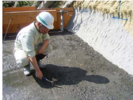
写真 3.4.3-2 GC状況の確認検査
