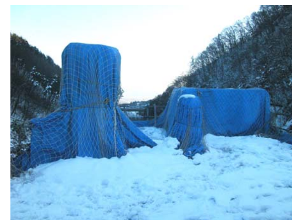
写真 3.4.31 エレベータ周辺部の越冬養生
