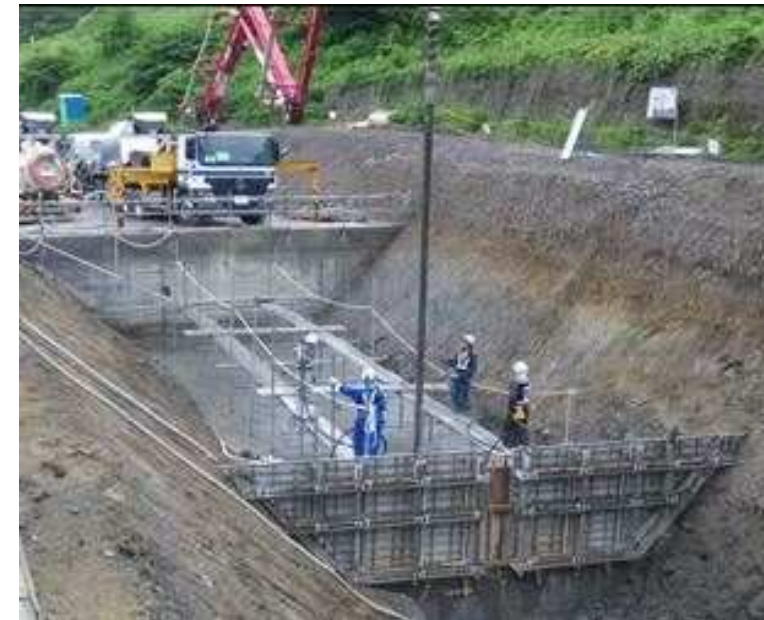
写真 3.6.1 河床部コンクリート (C 配合) 施工状況写真
