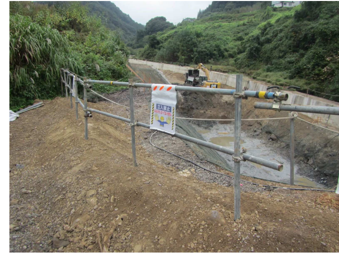
法肩区画状況
