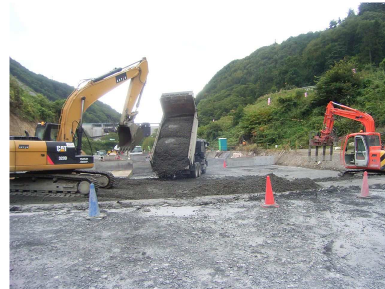
写真 3.6.2 河床部コンクリート上部のコンクリート (B2 配合) 施工状況写真
