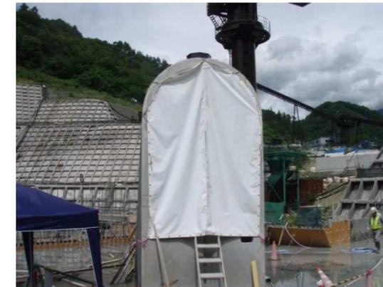
写真 3.4.17 監査廊入口ファスナーシート設置
