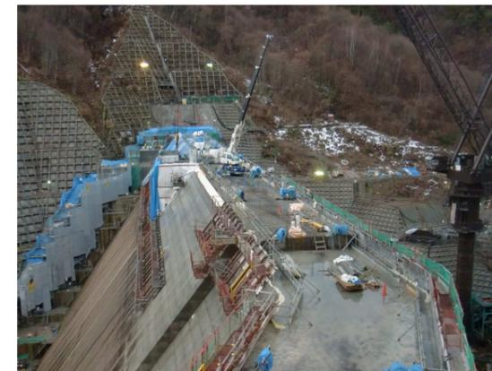
写真 3.4.29 斜面部の越冬養生施工状況
