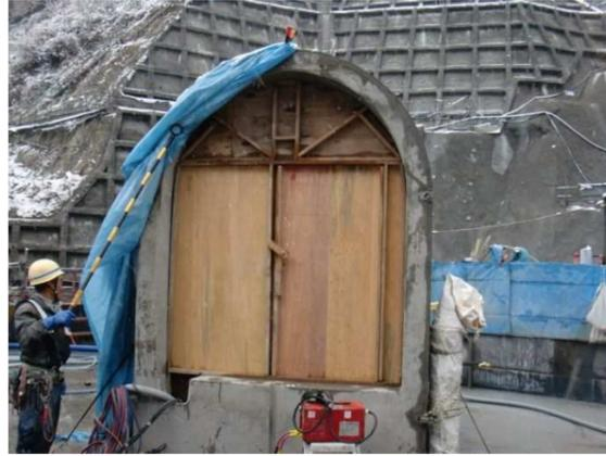
写真 3.4.33 監査廊入口扉設置(越冬養生)
