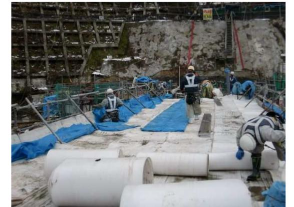
写真 3.4.28 水平打継面の越冬養生施工状況
