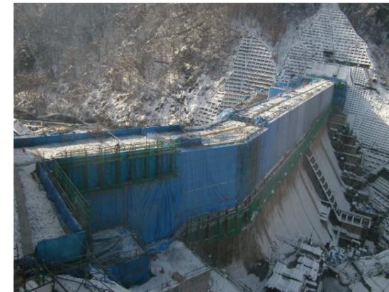
写真 3.4.27 水平打継面の越冬養生
