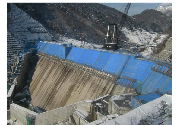
写真 3.4.32 下流面の越冬養生
