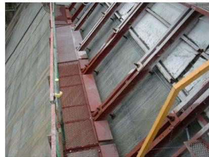
写真 3.4.12 斜面部の散水養生
