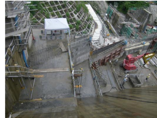
写真 3.4.15 導流壁部の散水養生
