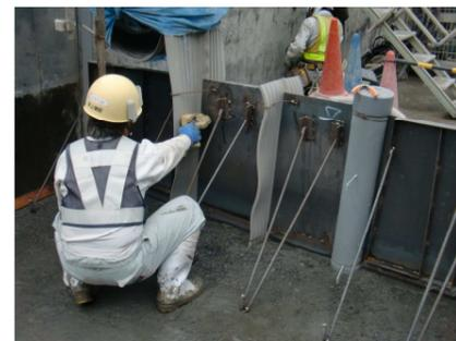
写真 3.4.8 止水板の清掃
